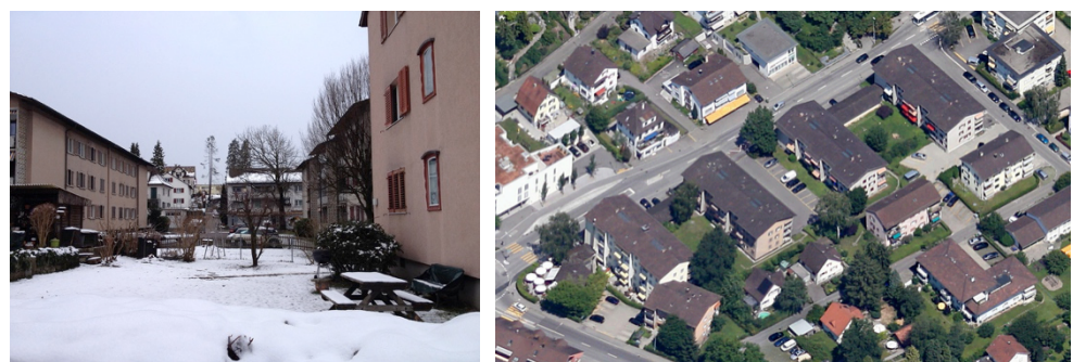
Abb. 16: 1950/1960er Bauten entlang der Wangenstrasse (Quelle: PLANAR / www.maps.google.de, 2015)
