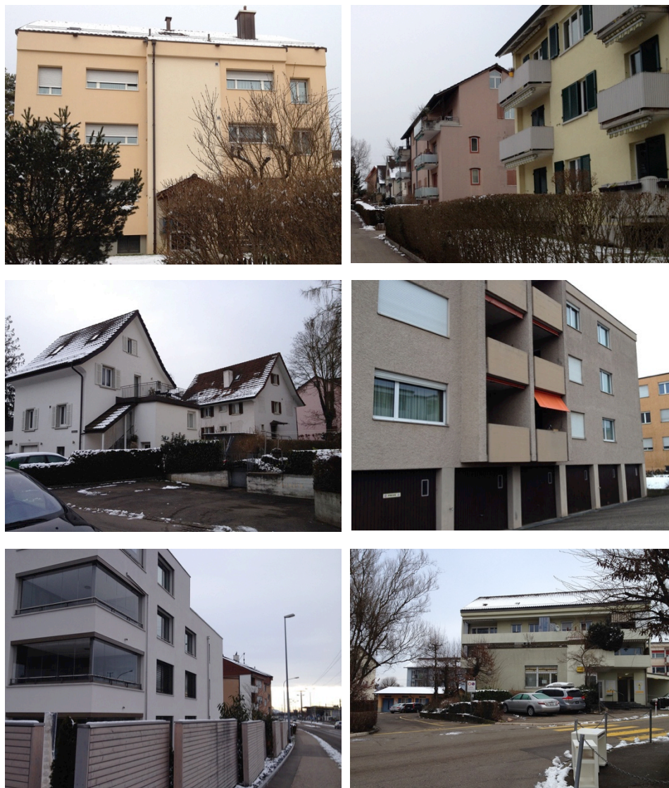
Abb. 14: Gebäudefassaden (Quelle: PLANAR, 2015)
