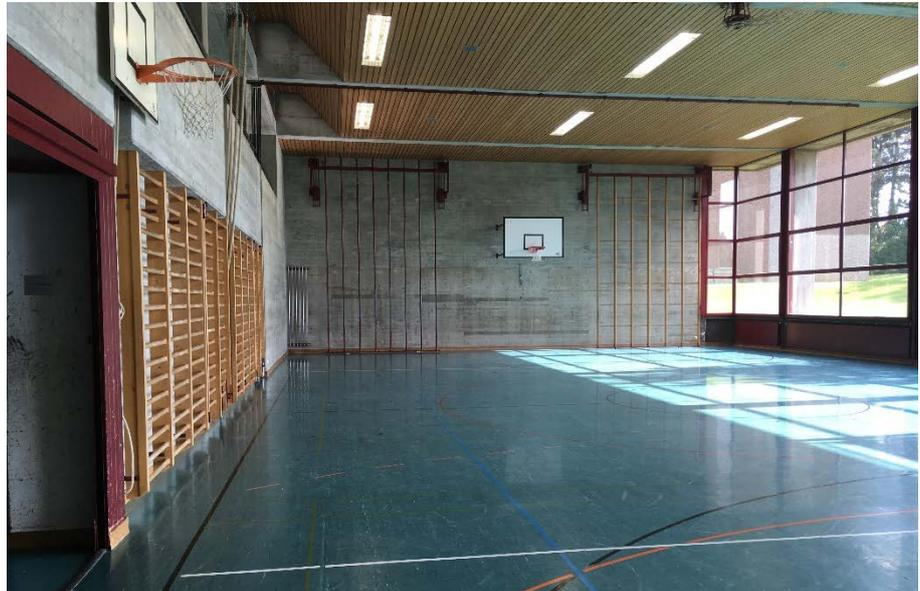
Abbildung 6: Hallenbereich der Einfachturnhalle Primarschule. Beton-Deckenunterzüge in Hallenquerrichtung, Querwände und nördliche Hallenwand in Sichtbeton.
