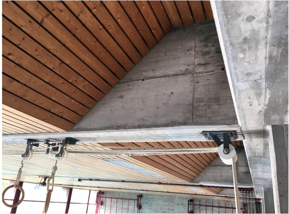
Abbildung 14: Detail Auflagersituation der Deckenunterzüge im Bereich der Galerie.
