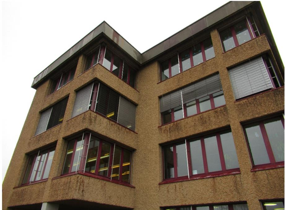
Abbildung 10: Ansicht Fassade mit über die Gebäudeecke führenden Fensteröffnungen und Fensterbrüstungen
