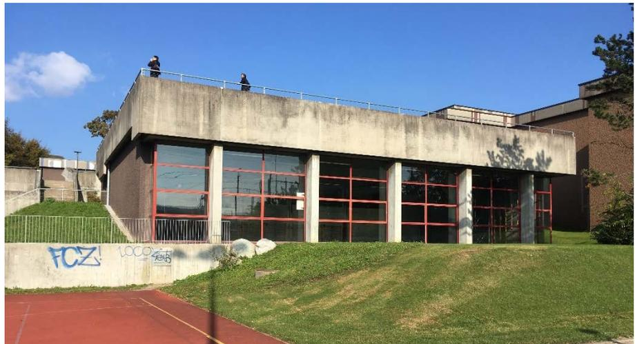
Abbildung 7: Aussenansicht der Einfachturnhalle Primarschule. Aufgelöste Südfassade mit Stahlbetonstützen.
