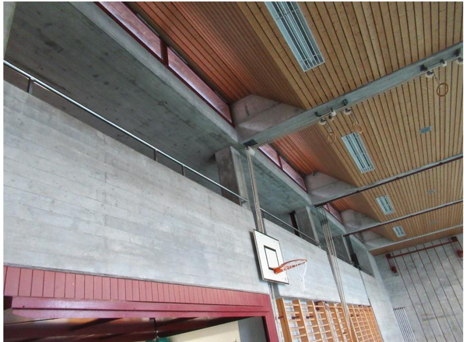
Abbildung 13: Nördliche Hallenwand mit Blick zur Galerie. Im UG01 Tragstruktur aufgelöst in Stützen.
