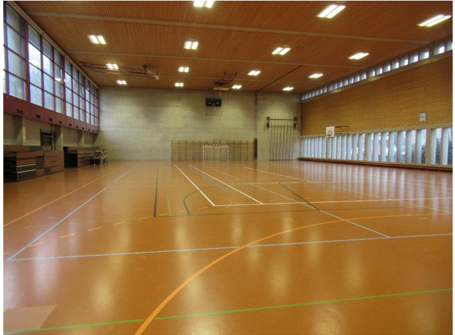
Abbildung 17: Sporthalle, Blickrichtung Ost, mit Hallenquerwand, Deckenunterzügen und aufgelösten Hallenlängswänden in Stahlbeton (Sichtbeton).
