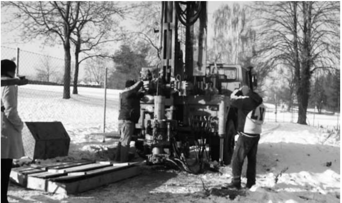
Beginn der Altlastenuntersuchungen (Probebohrungen) bei der Leichtathletikanlage Eichstock
