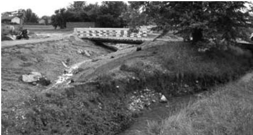
Blick auf den alten (mittlerweile trockengelegten, rechts) und den neuen Verlauf (links) des Sagentobelbachs südlich vom Bahnhof Stettbach
