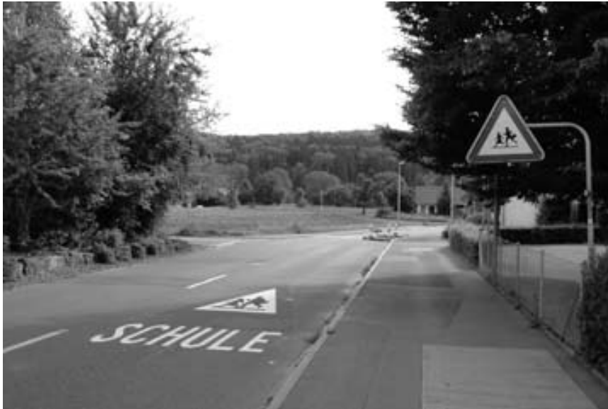
Neue Signalisation beim Schulhaus Wil
