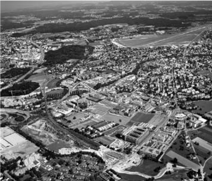
Ein aktuelles Luftbild Dübendorfs mit der Baustelle der ÖV-Plattform Stettbach im Vordergrund und den diversen Baustellen entlang des Verlaufs der neuen Glattalbahn (Sonnental, Giessen, Neugut)
