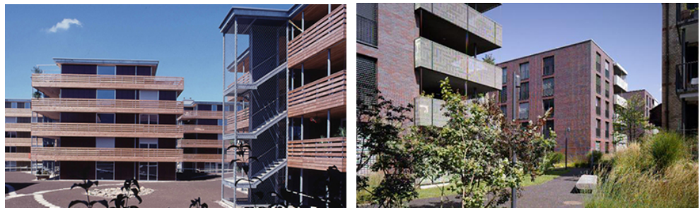
Abb. 30: 4-geschossige Wohnbebauung, Balance Wallisellen (li); 5-geschossige Bebauung, Sidi-Areal Winterthur (re) (Quelle: www.haerlehubacher.ch ; www.swiss-architects.com )
