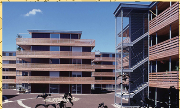
4-geschossige Wohnbebauung, Balance Wallisellen
