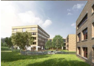
Schulanlage Rheinfelden Sanierung & Erweiterung Leistungsorientiert 144 Generalplaner Einzelleistungsträger
