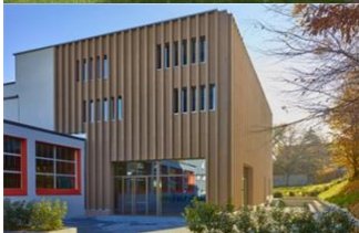
Sekundarschule Dielsdorf Sanierung & Erweiterung Planerwahlverfahren Kt. ZH Generalplaner Einzelleistungsträger
