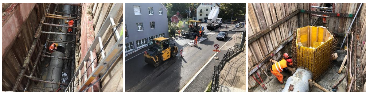
Kanalisations-, Belags- und Ortsbetonbau
