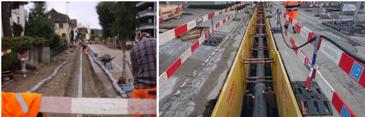
Pflasterungs-, Wasserleitungs- und Kanalisationsbau
