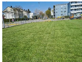
600 m 2 Rollrasen verlegt
