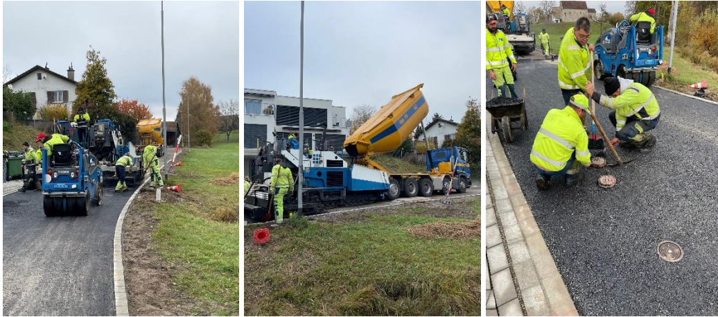
Einbau Tragschicht
