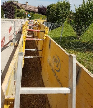
Gespriesster Graben für neue Kanalisation
