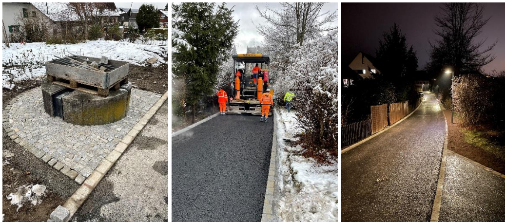
Pflästerung-und Belagsbau sowie Beleuchtung
