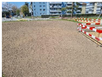
vor dem verlegen
