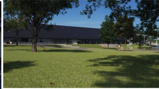
Hallensaal Dübendorf Dunkle Photovoltaik
