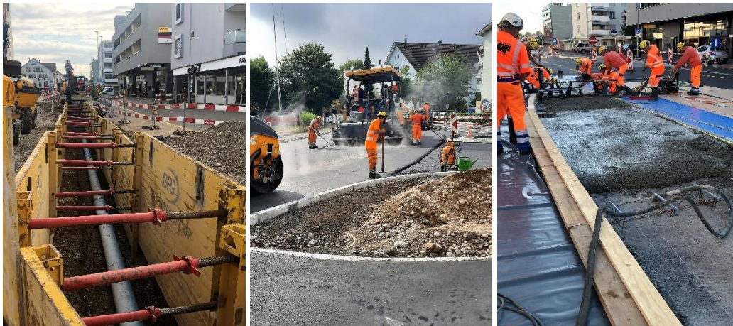
Werkleitungs-, Belags- und Betonarbeiten
