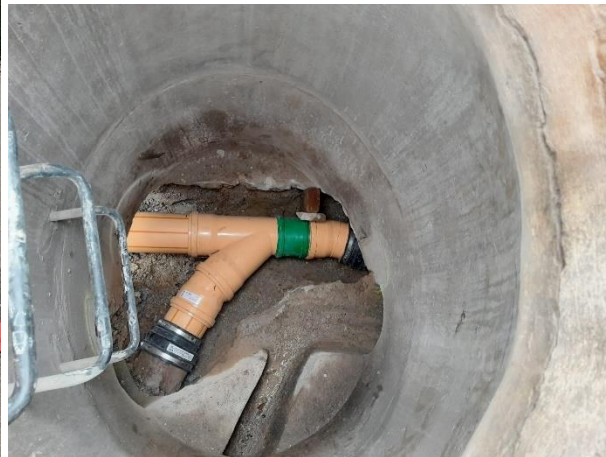
Sanierung von Schachtsohle
