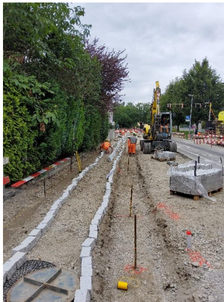
Absteckung für Randabschlüsse und Strassenfundation
