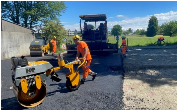
Der Vorplatz während dem Einsetzen des Belags
