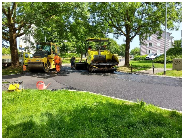
Deckbelageeinbau mit Einbaumaschine (Fertiger)
