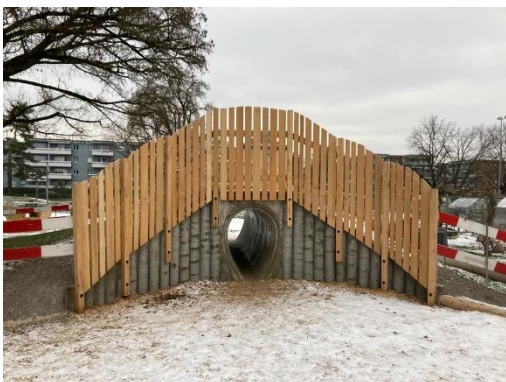
Röhre mit Brüstung
