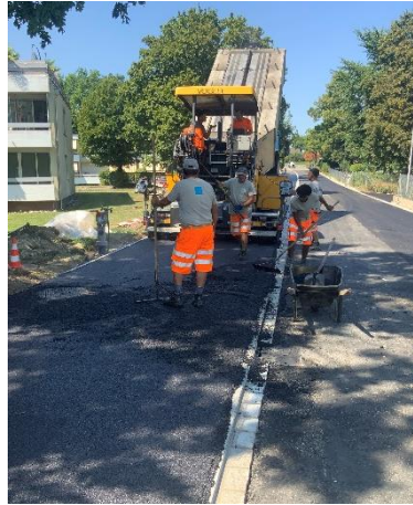
Belageeinbau mit Fertiger
