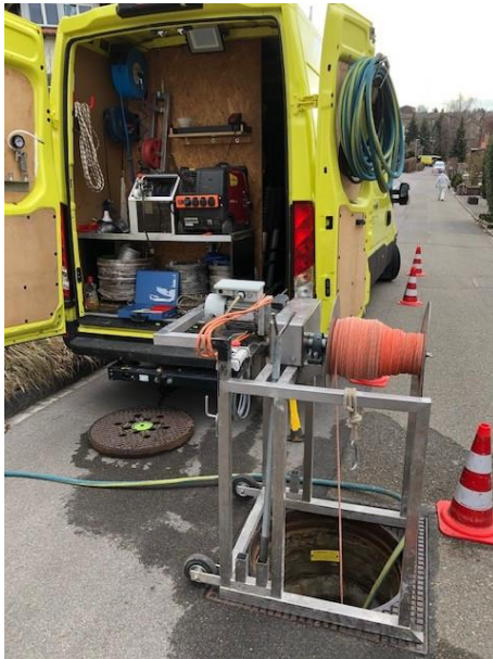
Installation für Inliner
