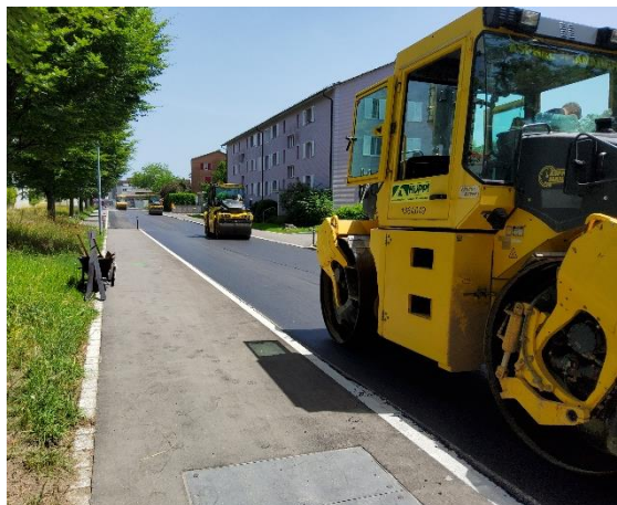
Belagsverdichtung mit Walzen
