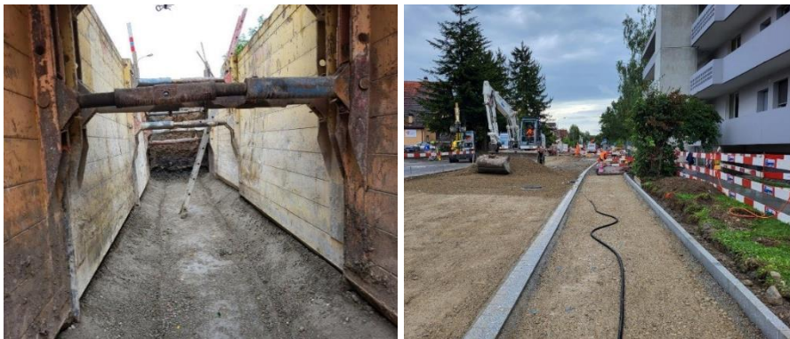
Grabenspriessung für Kanalisation
