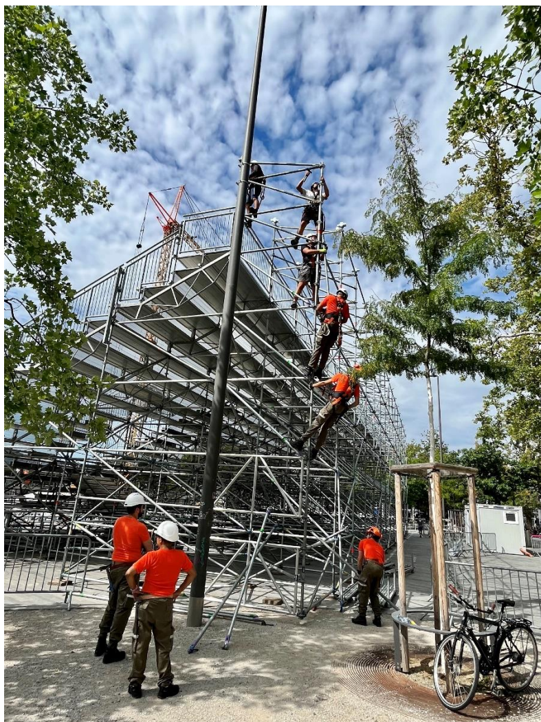
Aufbauarbeiten für Weltklasse Zürich
