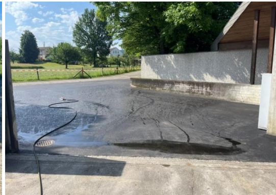
Der fertiggestellte Vorplatz
