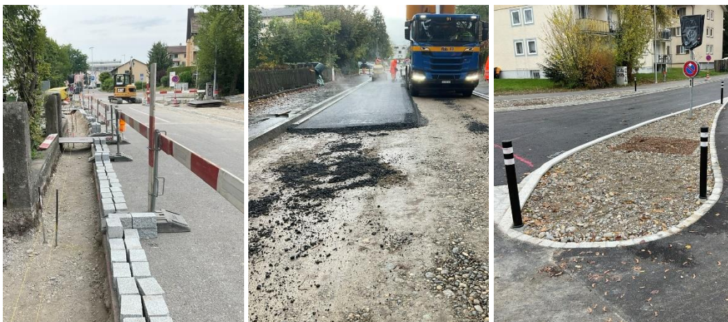
Pflästerung- und Belagsarbeiten sowie neu geschaffene Baumgruben
