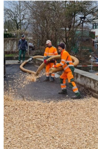
Einbau Holzschnitzel als Fallschutz
