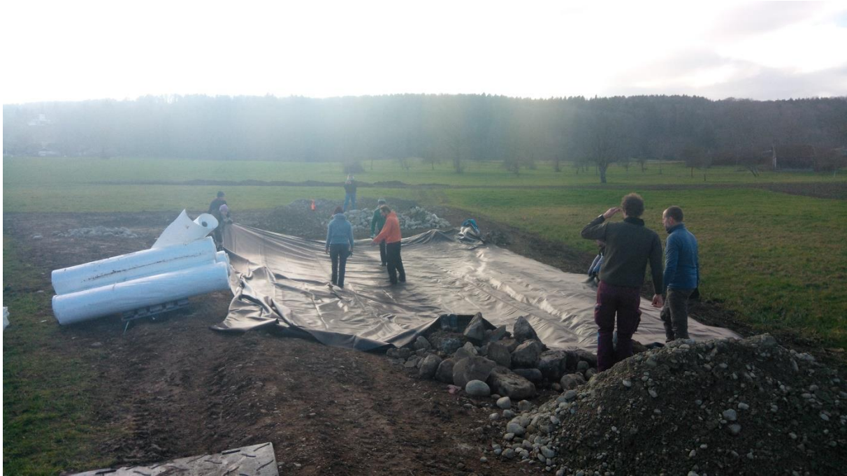
Aufwertungsprojekt Chürzi/Seewadel während dem Bau im Februar 2023
