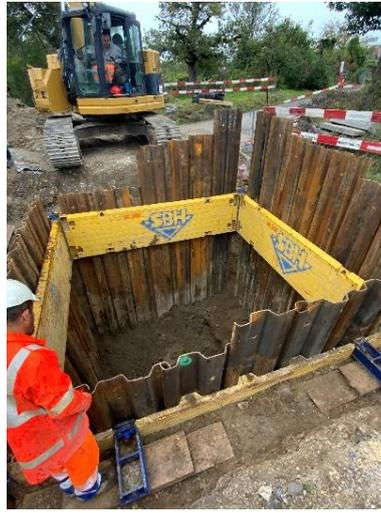
Baugruben für Pumpenschacht
