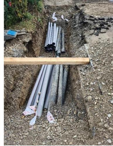
Neue Kabelschutzrohre für Strom
