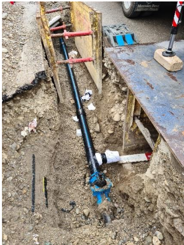
Neue Wasserleitung
