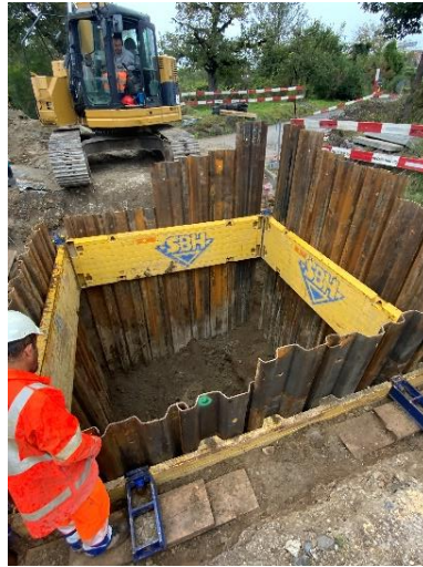
Baugruben für Pumpenschacht
