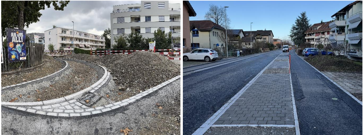
Pflasterungsarbeiten und bereits neu realisierter Strassenraum
