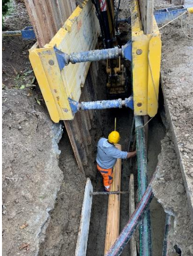
Werkleitungsgraben gespriesst
