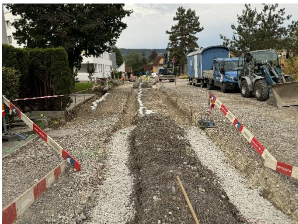
Einbau überbaubares Pflanzensubstrat und neu geschaffener Strassenraum
