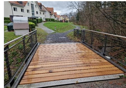
Brücke nach der Sanierung
