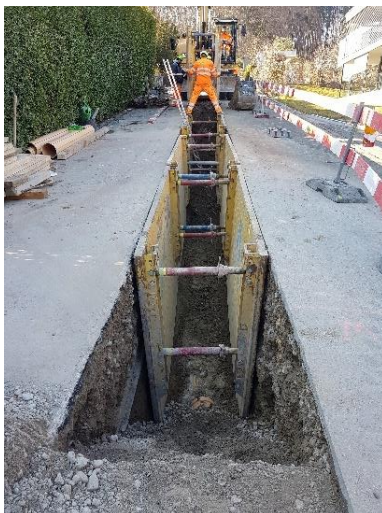
Gespriesster Graben für Werkleitungen
