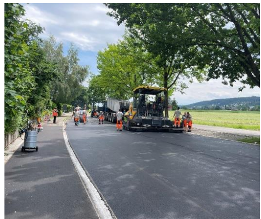
Einbau Deckschicht
