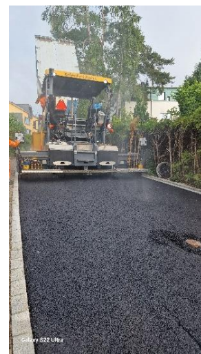
Deckbelageeinbau
