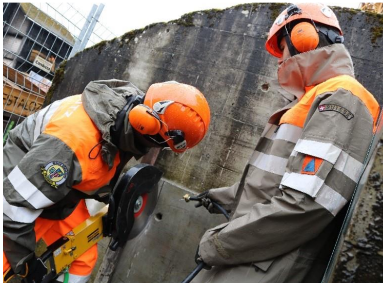
Zivilschutz WK Technische Hilfe – Zivilschützer bei der Arbeit mit schwerem Gerät
