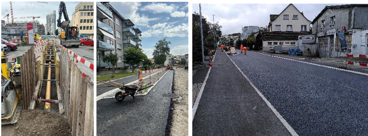
Graben für Kanalisation
