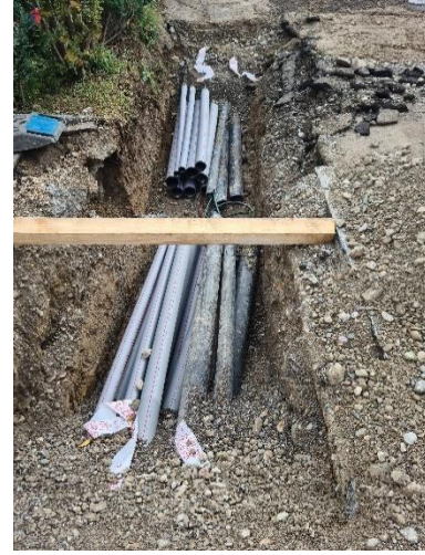
Neue Kabelschutzrohre für Strom
