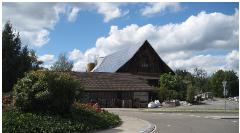
Referenzbild Solaranlage, Wädenswil
