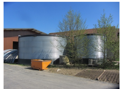
bestehende Wassertanks, Hermikon
