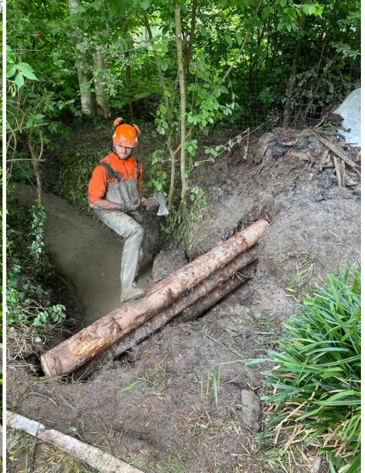
WK Technische Hilfe Erstellung einer Bachverbauung
