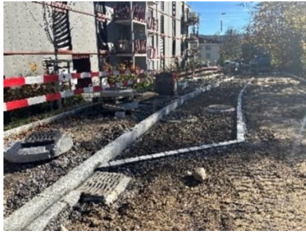
Rabatten mit Substratfüllung
