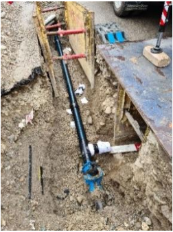
Neue Wasserleitung
