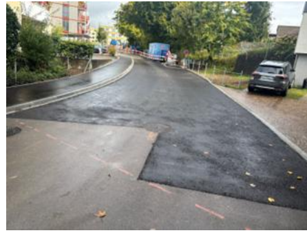
Eingebaute Tragschichten
