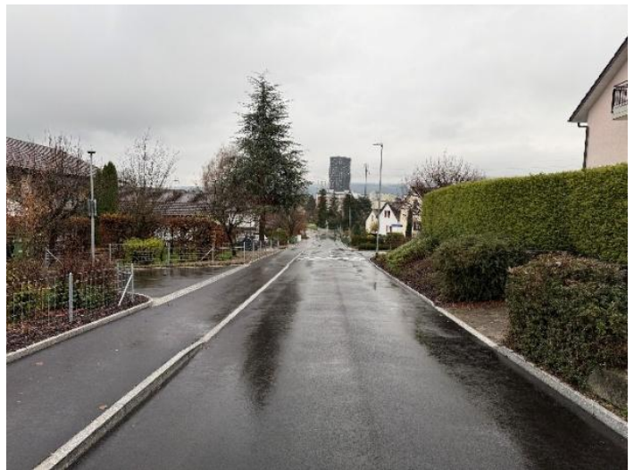
Zustand nach Ausführung
