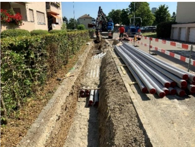
Graben für Kabelschutzrohre (Strom und Beleuchtung)
