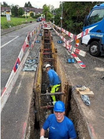
Gespriesster Graben für Wasserleitung
