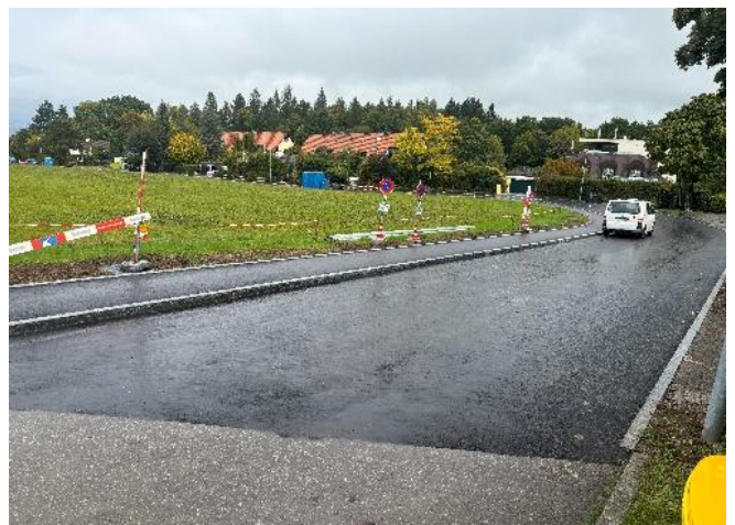
Eingebaute Tragschicht in der Fahrbahn
