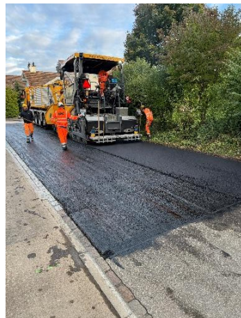
Neuer Strassenraum während Deckbelagsarbeiten und bereits neu realisierter Strassenraum inkl. Bepflanzung
