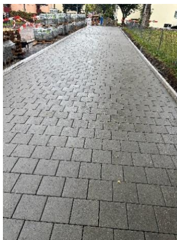
Sickersteine im Parkplatz
