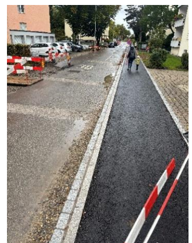
Eingebaute Tragschicht im Gehweg
