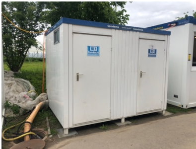
Bild Sanitäranlagen heute
