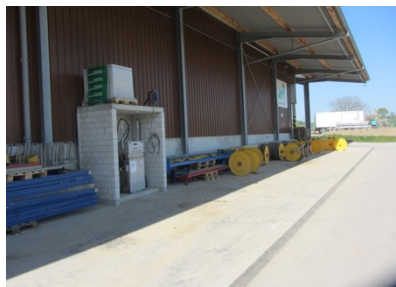
bestehende Tankstelle, Hermikon
