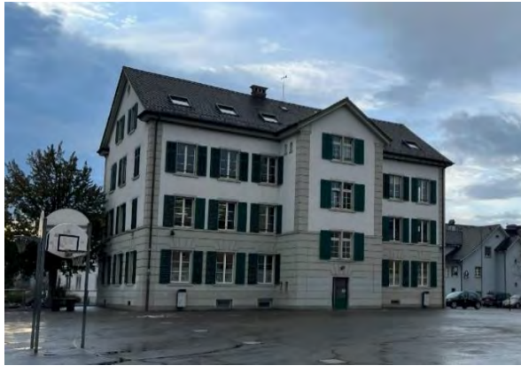
Fassade zu Pausenplatz
