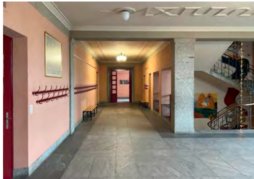
Haus B - Erhalt der historischen Fassung der Treppenhalle
