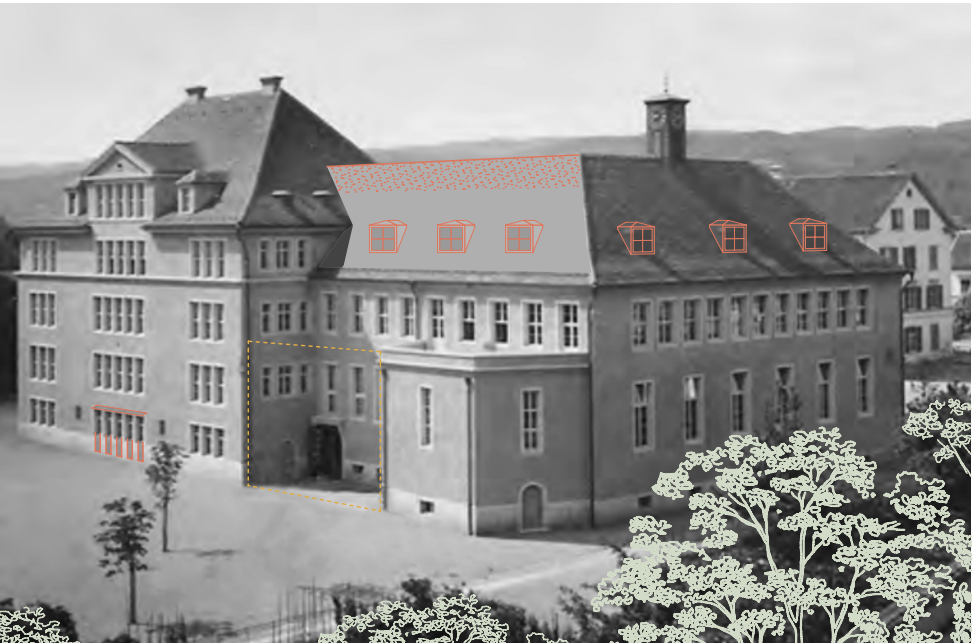
Rückbau der nachträglichen Erweiterung
