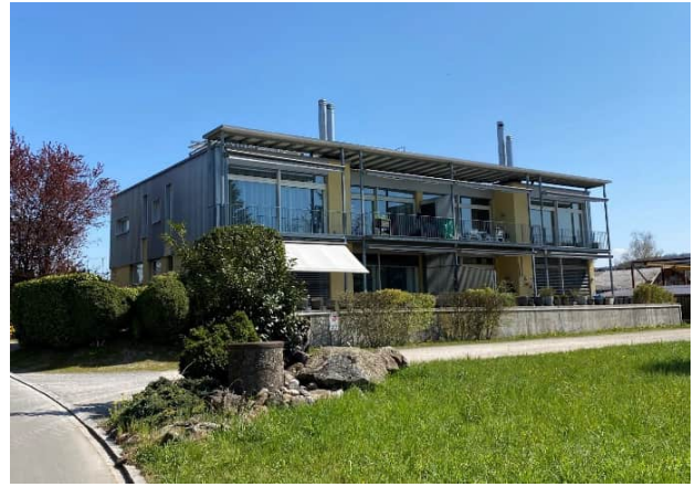
Abbildung 47: Eher für Kernzonen und Weiler untypische Flachdachbaute
