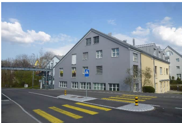
Abbildung 228: Gebäude Verzweigung Gockhauserstr. / Obere Geerenstr.
