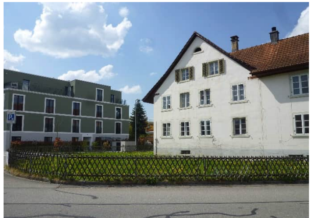
Abbildung 196: historisch wertvolles Gebäude Grundstück Nr. 11706 (Südseite)
