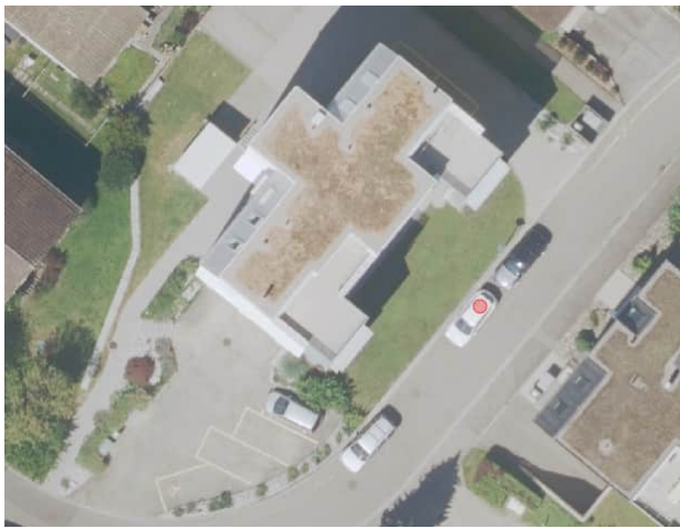
Abbildung 74: Flächige, asphaltierte Abstellflächen und Zufahrten (keine Aussenraumqualität)
