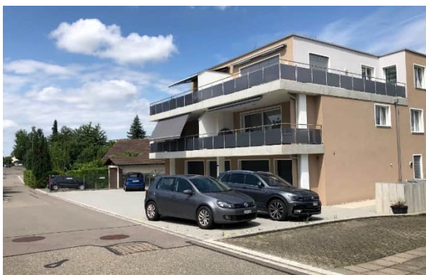
Abbildung 76: Fehlende Grünraumfläche entlang des öffentlichen Raums
