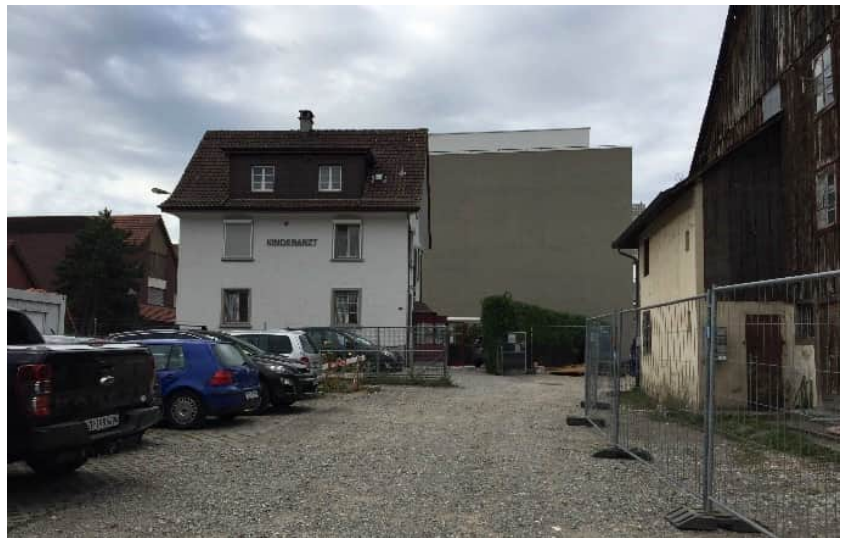
Abbildung 175: Gebäude auf dem Grundstück Nr. 13933 und hinterliegender Flachdachbaute
