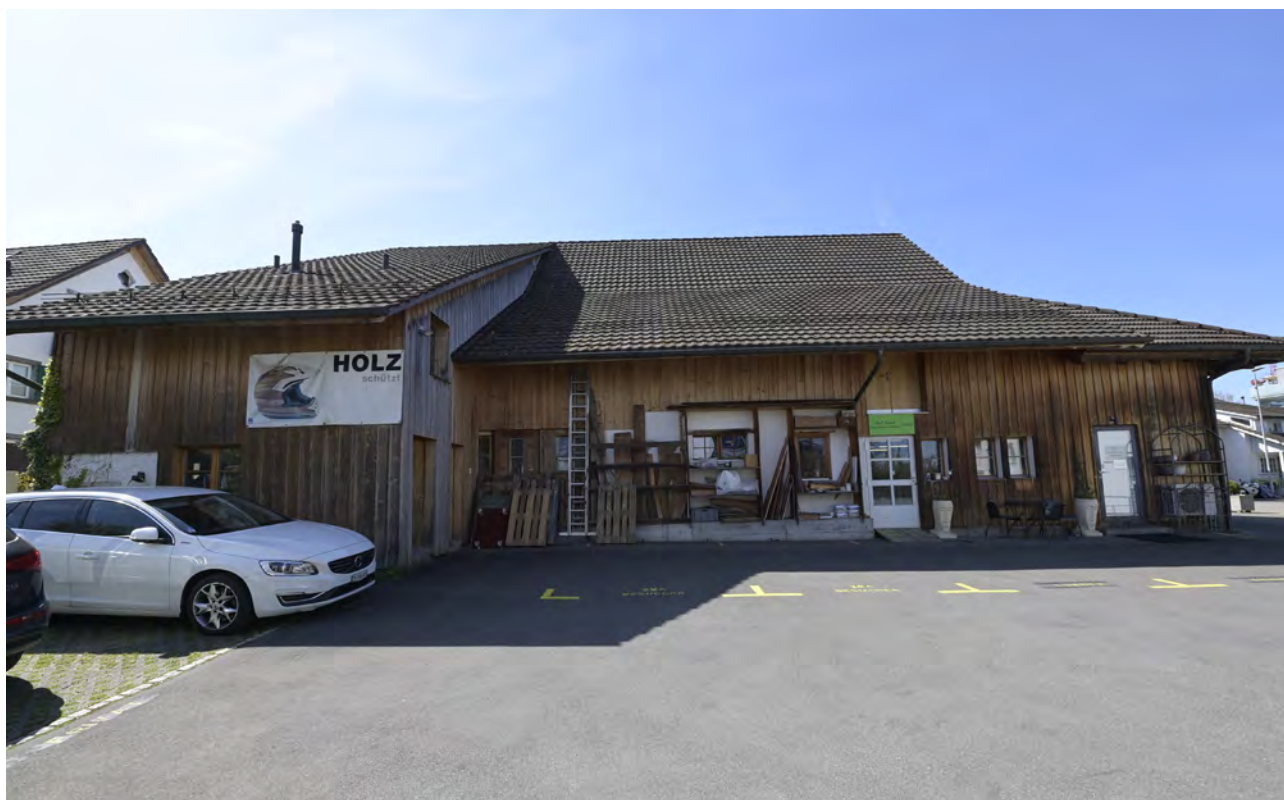
Wallisellenstrasse 28 | Blick von Norden | vestigia 08.04.2025
