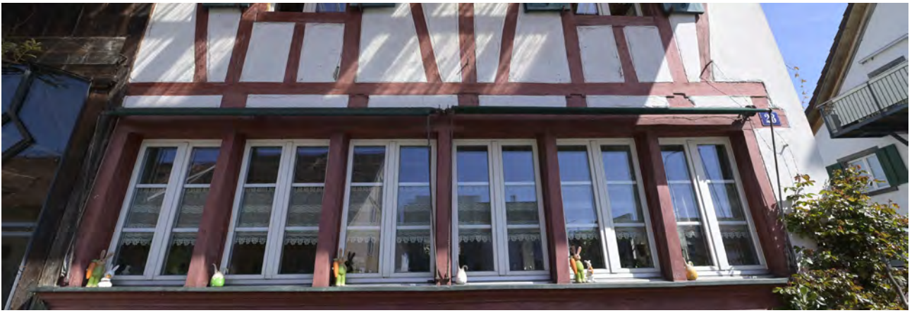
Wallisellenstrasse 28 | Fassadendetail | vestigia 08.04.2025
