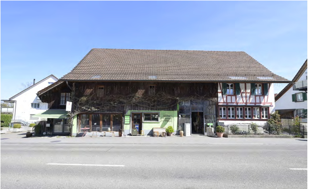
Wallisellenstrasse 28 | Blick von Süden | vestigia 08.04.2025
