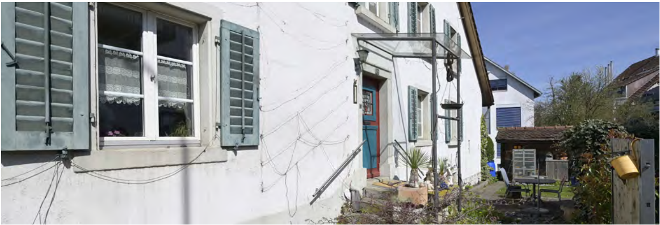
Wallisellenstrasse 28 | Fassadendetail | vestigia 08.04.2025
