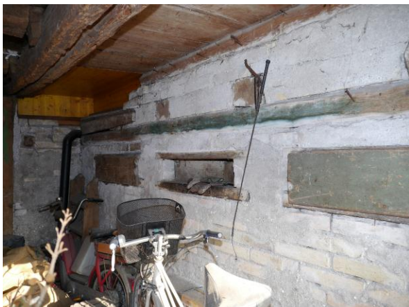
Abb. 86: Raum 0.02, Blick Richtung Nordwesten mit Futteröffnungen.
