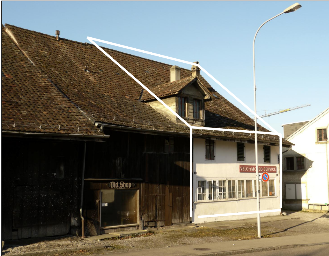
Abb. 52: Anstelle eines älteren Gebäudes wurde 1850 – 52 der heutige, für zwei Parteien konzipierte, Hausteil errichtet.
