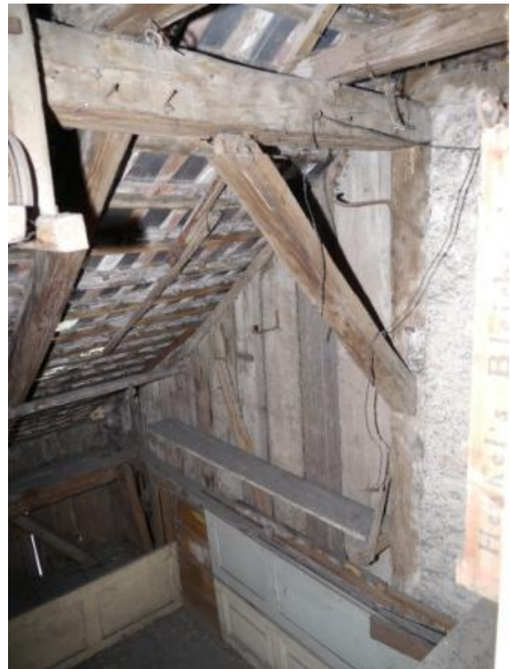
Abb. 209: Raum 2.18, Blick Richtung Osten.
