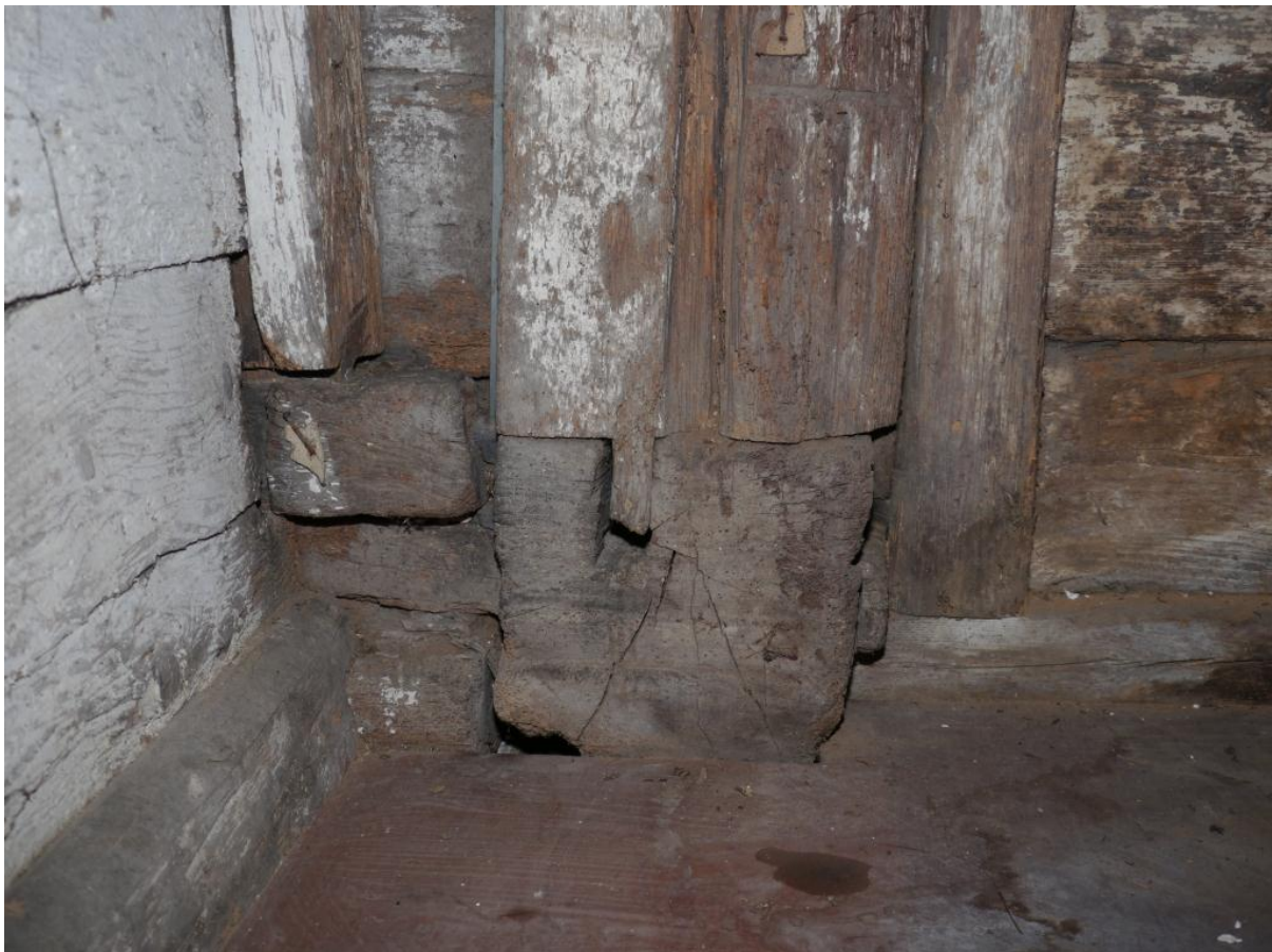
Abb. 40: Schwellen mit darauf stehendem Ständer im Raum 0.09
