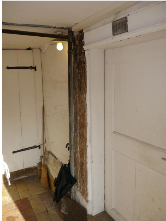
Abb. 39: Wandständer im Raum 0.04
