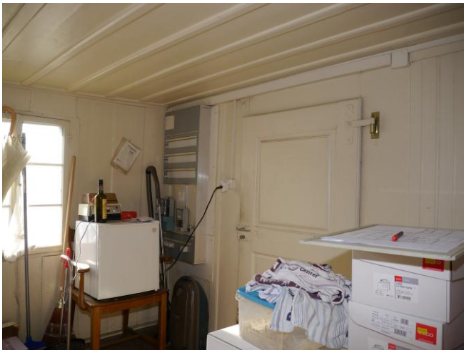
Abb. 88: Raum 0.03, Blick Richtung Südosten.
