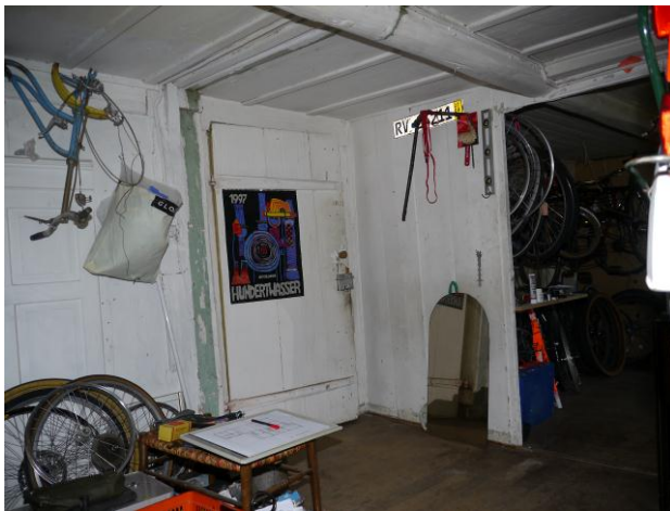
Abb. 155: Raum 1.07, Blick Richtung Nordosten. Links neben der Türe der ehemalige Ständer der 1. Bauphase.
