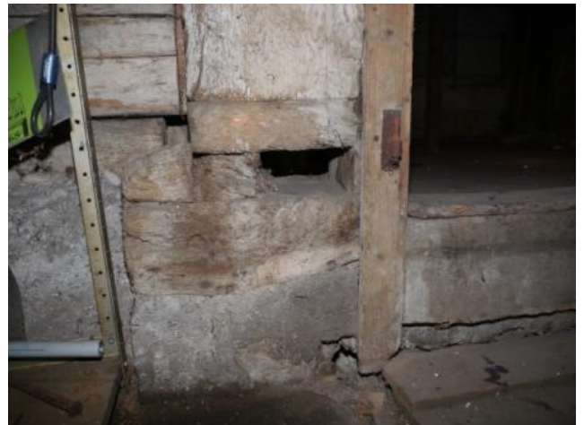
Abb. 101: Raum 0.09, Eckständler mit Schwelle der 1. Bauphase.
