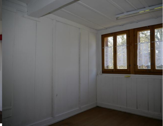
Abb. 106: Raum 0.11, Blick Richtung Süden.
