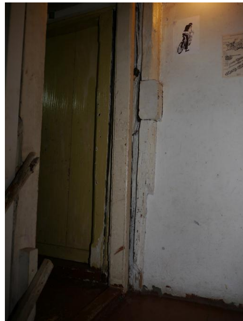
Abb. 154: Raum 0.06, Blick Richtung Süden. Ehemaliger Ständer der 1. Bauphase als nachträgliches Türgewände.
