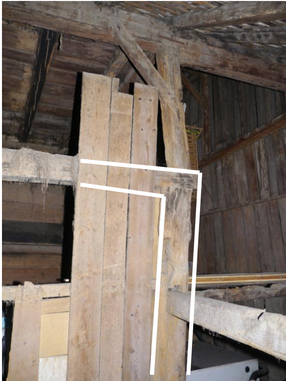
Abb. 35: Eckständer des Wohnteils mit darauf gestelltem Dachstuhl der Phase II.
