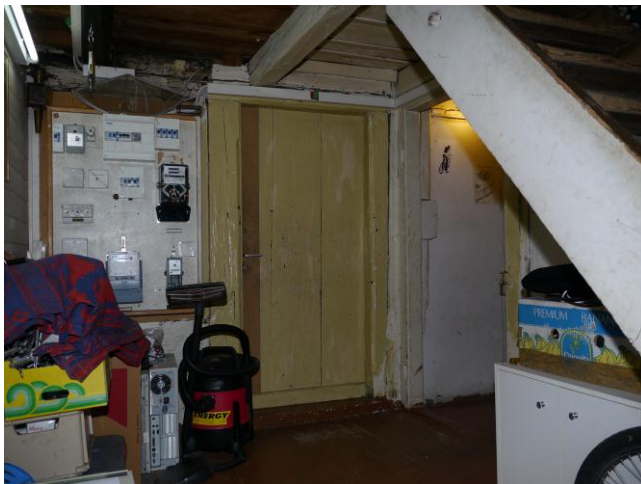
Abb. 153: Raum 1.06, Blick Richtung Süden. Türdurchgang zu Raum 1.07.
