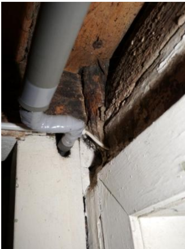
Abb. 104: Raum 0.10, Blick gegen Nordosten. Reste des ehemaligen Mittelständers.
