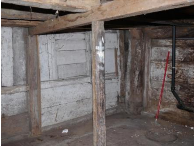
Abb. 98: Raum 0.09, Blick Richtung Südosten. Ehemaliger Mittelständler der 1. Bauphase mit Nut.
