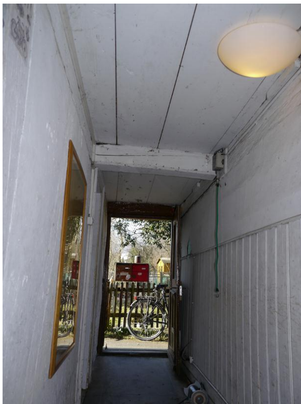
Abb. 109: Raum 0.13, Blick Richtung Süden.
