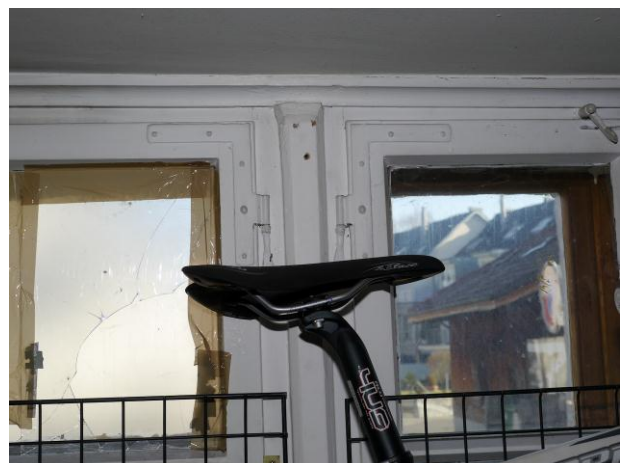
Abb. 130: Raum 0.20, Blick Richtung Norden. Detail Beschlagsbänder.
