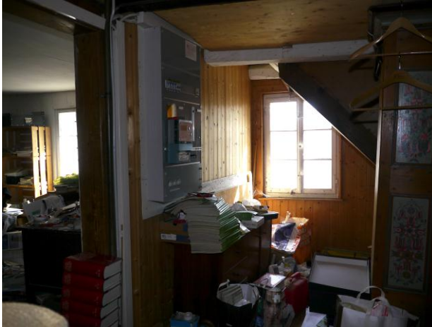
Abb. 149: Raum 1.02, Blick Richtung Osten.
