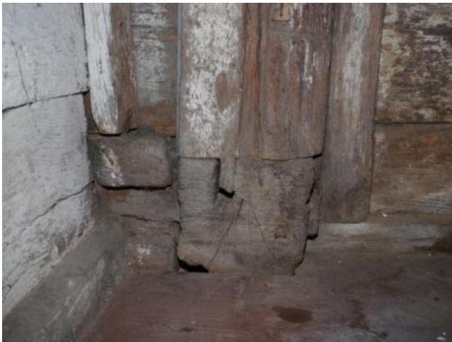
Abb. 100: Raum 0.09. Mittelständler in der Südostecke mit Schwelle.
