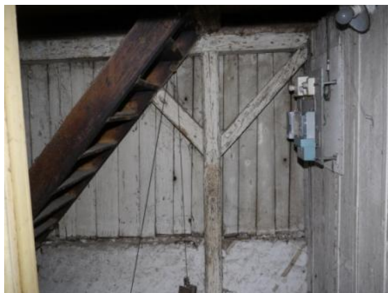
Abb. 204: Raum 2.15, Blick Richtung Süden.
