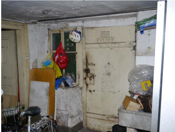
Abb. 136: Raum 0.25, Blick Richtung Westen mit Eingangstür.
