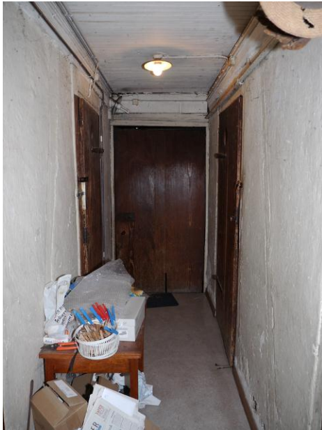
Abb. 142: Raum 0.28, Blick Richtung Norden mit Türen des Raums 0.31 links und Raums 0.17 rechts.
