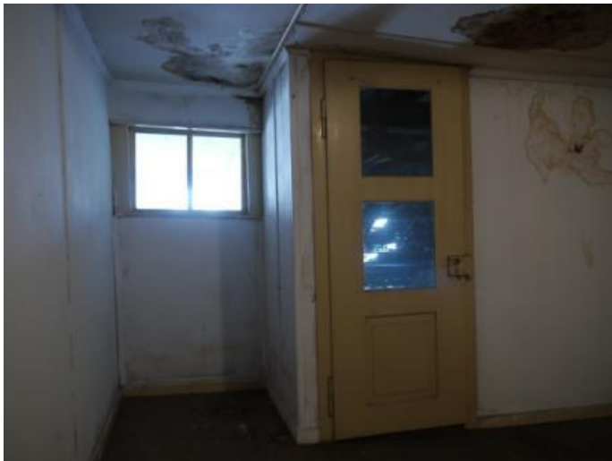
Abb. 207: Raum 2.17, Blick Richtung Norden, Türe zu Raum 2.18.
