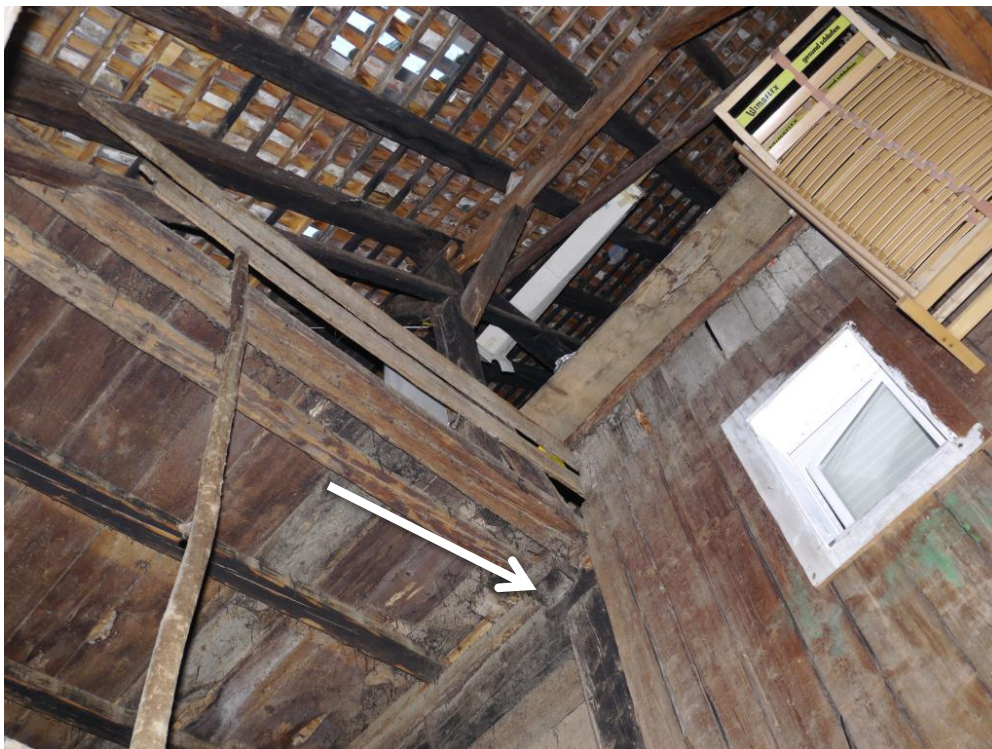
Abb. 37: Aufnahme der Tenne (Raum 0.14), Firstständer mit Firststrähm des Ständer-Bohlenbaus. Darüber steht der Dachstuhl der Phase II.
