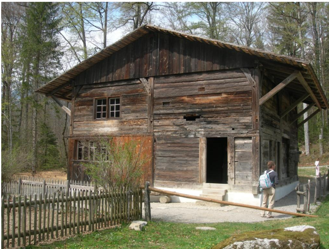
Abb. 34: Vergleichsbeispiel eines Ständer-/Bohlenbaus im Freilichtmuseum Ballenberg. Das Gebäude stammt aus Wattwil, Kanton St. Gallen und ist 1454 errichtet worden.
