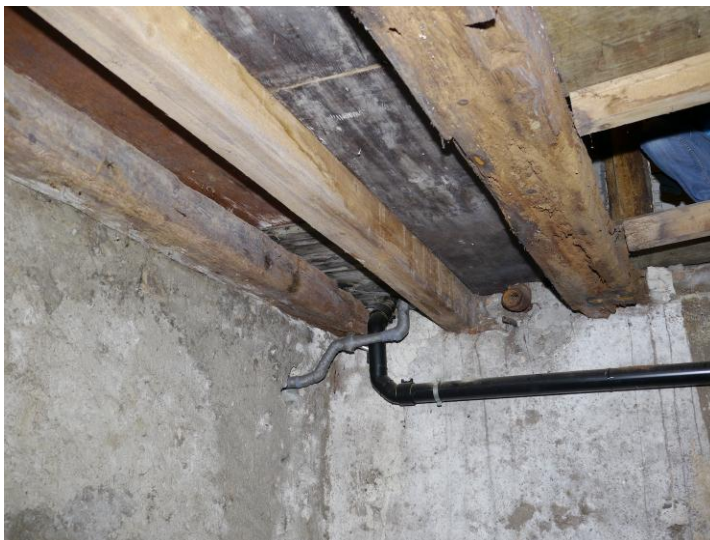
Abb. 77: Raum -0.01, Blick Richtung Südwesten.
