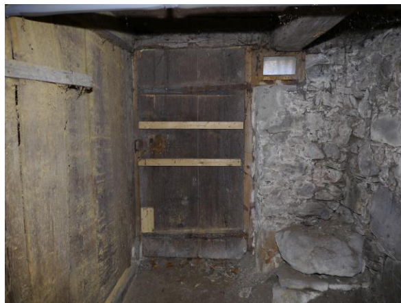
Abb. 79: Raum -0.02, Blick Richtung Osten.
