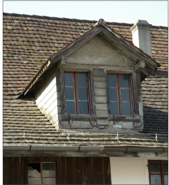
Abb. 56: Später aufgebaute Lukarne für eine Schlafkammer.
