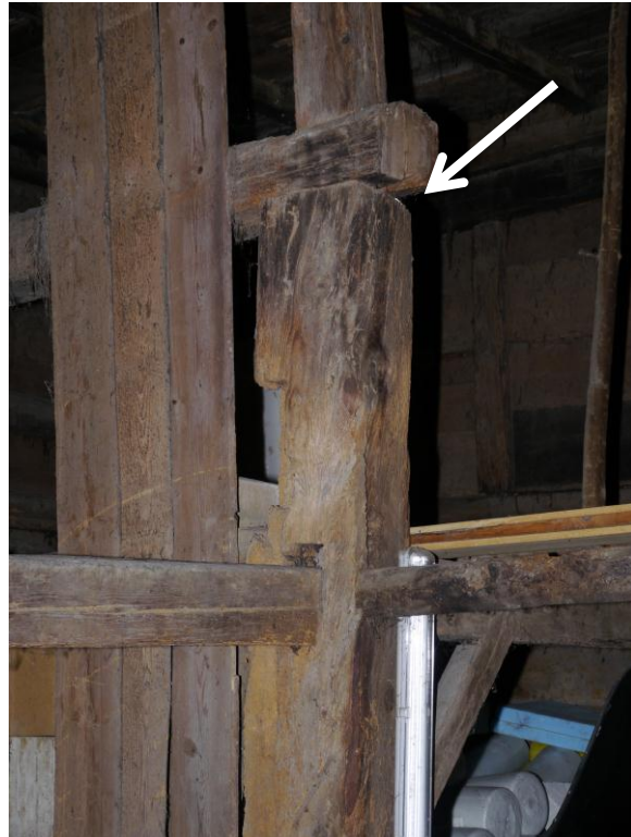
Abb. 36: Detail – oberer Abschluss des Ständer-Bohlenbaus.
