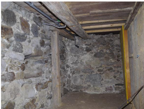
Abb. 78: Raum -0.02, Blick Richtung Südwesten. In der Südwand eine Mauernische.
