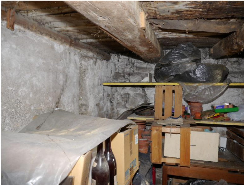
Abb. 85: Raum 0.01, Blick Richtung Westen.
