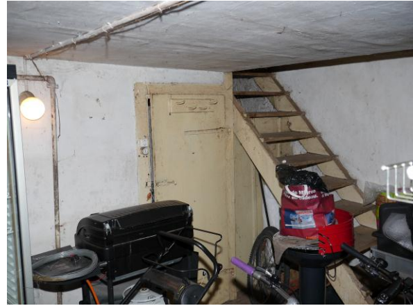
Abb. 137: Raum 0.25, Blick Richtung Nordosten mit Treppenaufgang zu Raum 1.0000.
