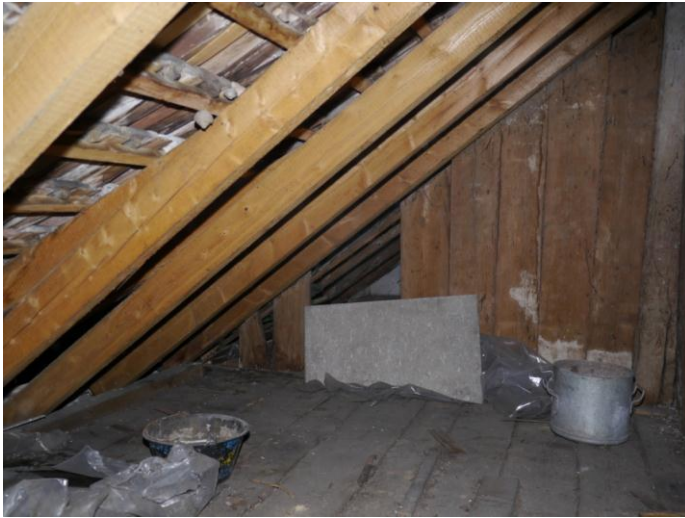
Abb. 202: Raum 2.14, Blick Richtung Osten.
