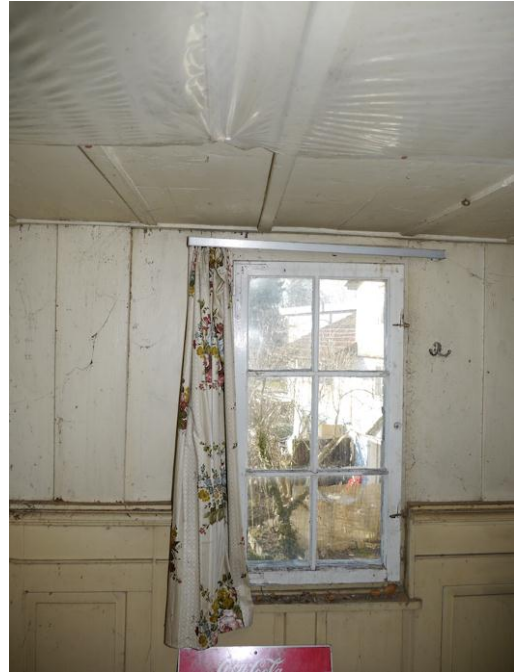
Abb. 174: Raum 1.18, Blick Richtung Westen.
