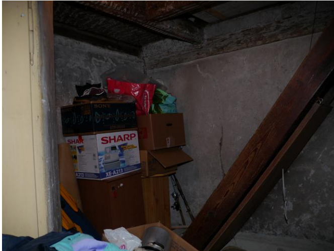
Abb. 180: Raum 1.22, Blick Richtung Südosten. Treppenaufgang zu Raum 2.15.
