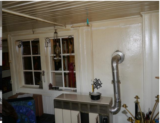
Abb. 185: Raum 2.02, Blick Richtung Norden.
