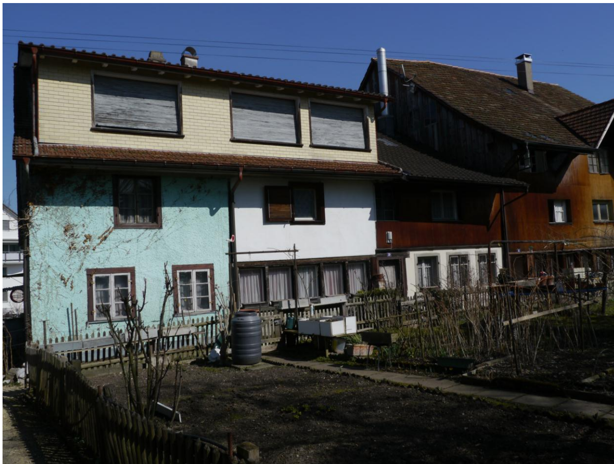
Abb. 60: Einfache Südfassade ohne Fensterwagen im Erdgeschoss. Der grosse Dachaufbau wurde erst 1966 errichtet.
