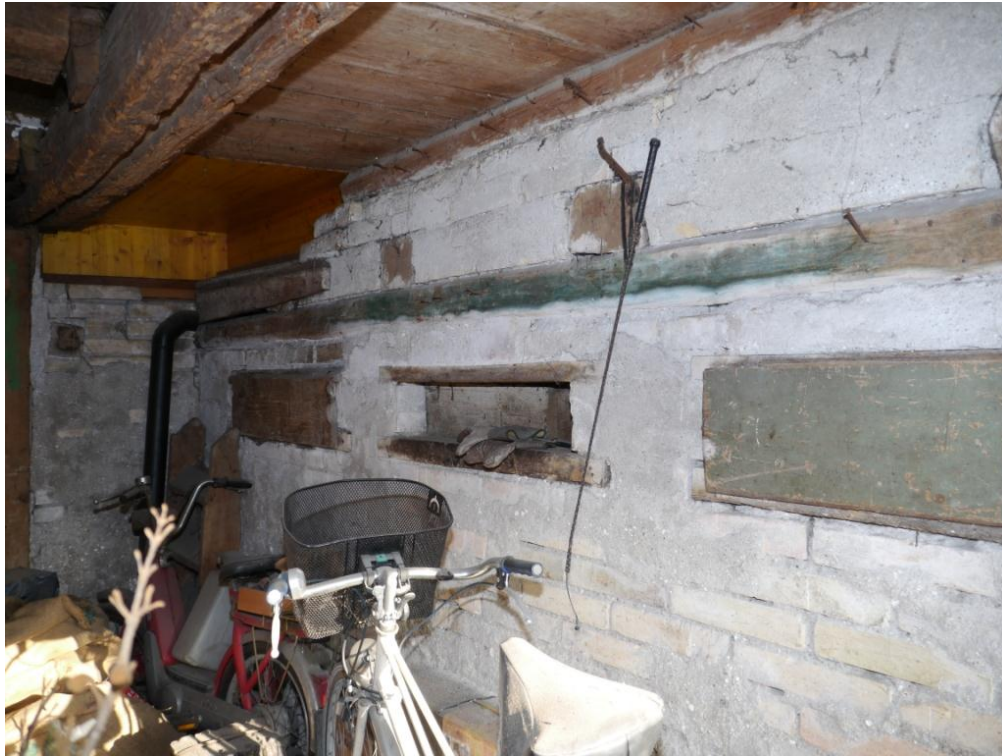
Abb. 67: Futterluken im östlichen Stall. Der genutete Deckenbalken gehört noch zur Phase I (Ständer-/Bohlenbau).
