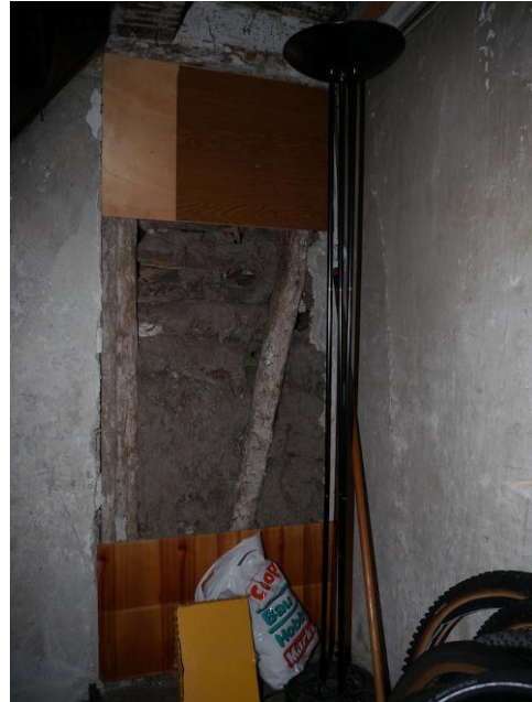
Abb. 181: Raum 1.22, Blick Richtung Süden. Zugemauert.
