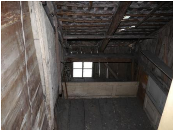
Abb. 208: Raum 2.18, Blick Richtung Norden.
