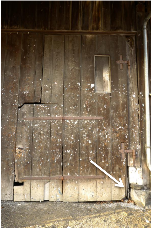
Abb. 48: Nachträgliches Tenntor. Der Eckständer mit Schwelle und darunter liegendem Widerlagerstein stammen aus der Bauzeit.
