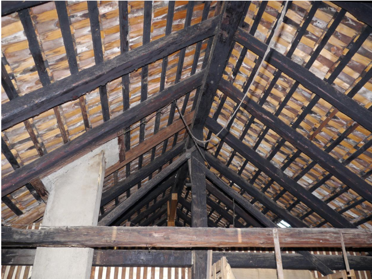
Abb. 42: Das imposante Dachwerk mit einer Spannweite von 12.5 m Breite hat sich fast vollständig erhalten. Er gibt mit seinem Alter von ca. 500 Jahren Zeugnis von der hohen Qualität der Zimmermannskunst der damaligen Zeit.
