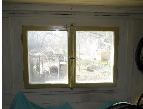
Abb. 158: Raum 1.08, Blick Richtung Süden. Verkleinertes Fenster.
