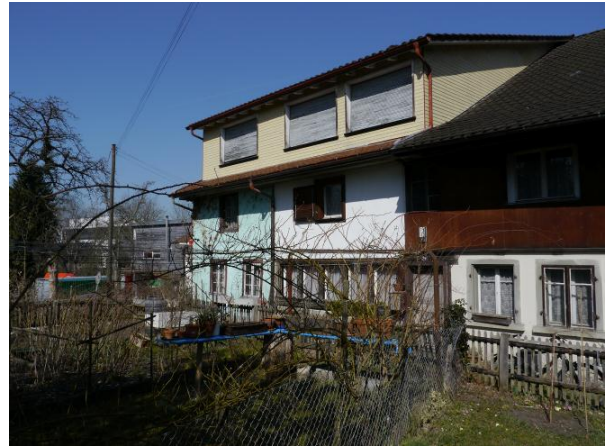
Abb. 75: Südfassade mit westlichem Hausteil.
