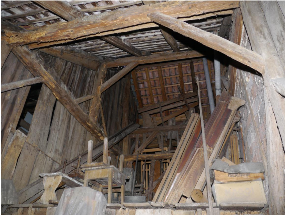
Abb. 50: Blick in den Dachraum.
