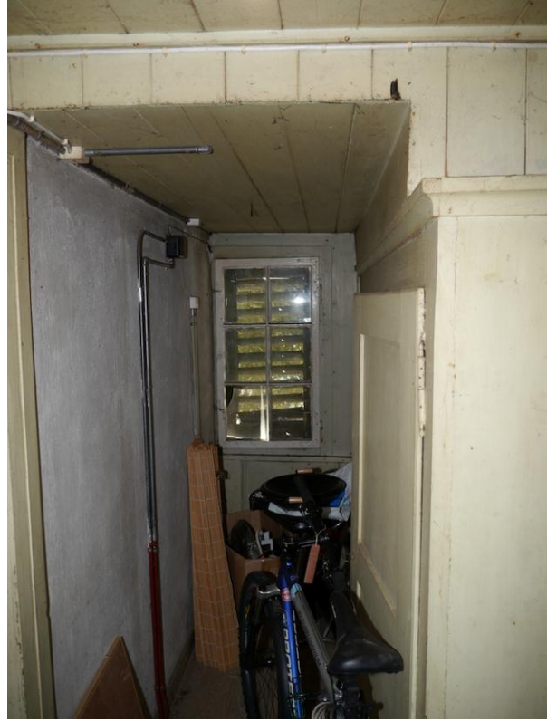
Abb. 172: Raum 1.17, Blick Richtung Westen.
