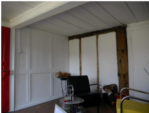
Abb. 107: Raum 0.12, Blick Richtung Nordwesten.
