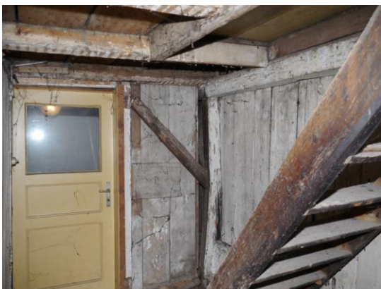
Abb. 203: Raum 2.15, Blick Richtung Osten.
