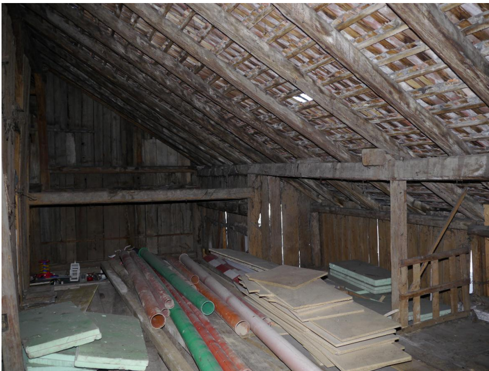
Abb. 113: Raum 0.14 (über Raum 0.01 und 0.0), Blick Richtung Nordwesten.
