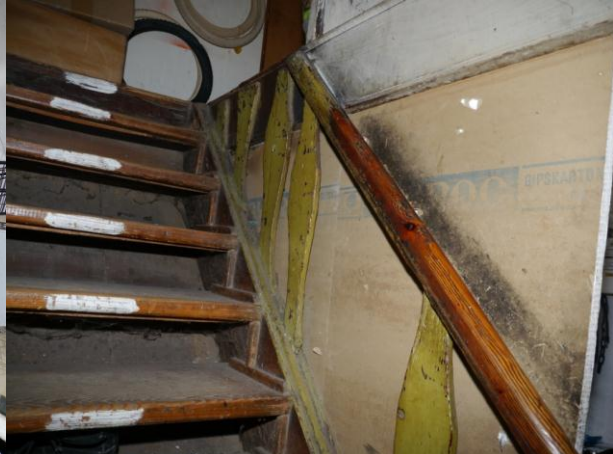
Abb. 135: Raum 0.23, Handlauf mit Balusterblättern.
