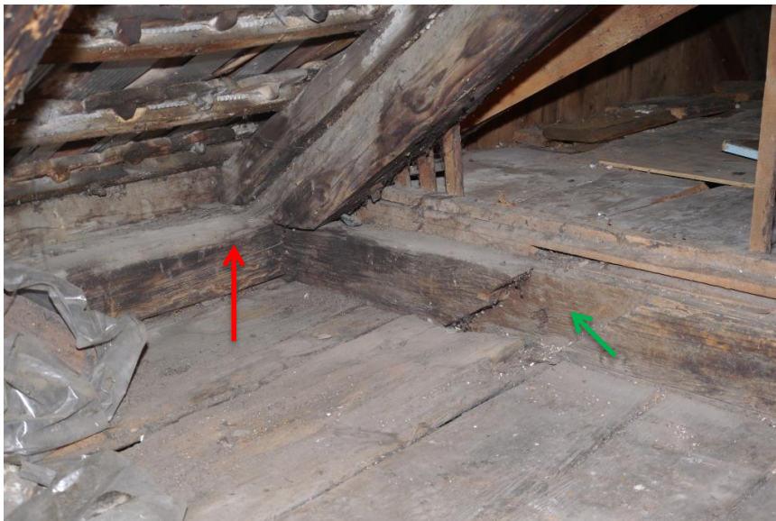
Abb. 43: Der eigenständige Abbund des Dachstockes über der abschliessenden Bretterlage des Unterstockes verleiht dem Dachwerk in folge seiner Seltenheit eine übergeordnete Bedeutung.
