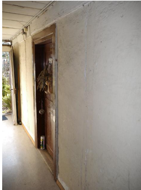
Abb. 143: Raum 0.28, Blick Richtung Süden mit Türe von Raum 0.27.
