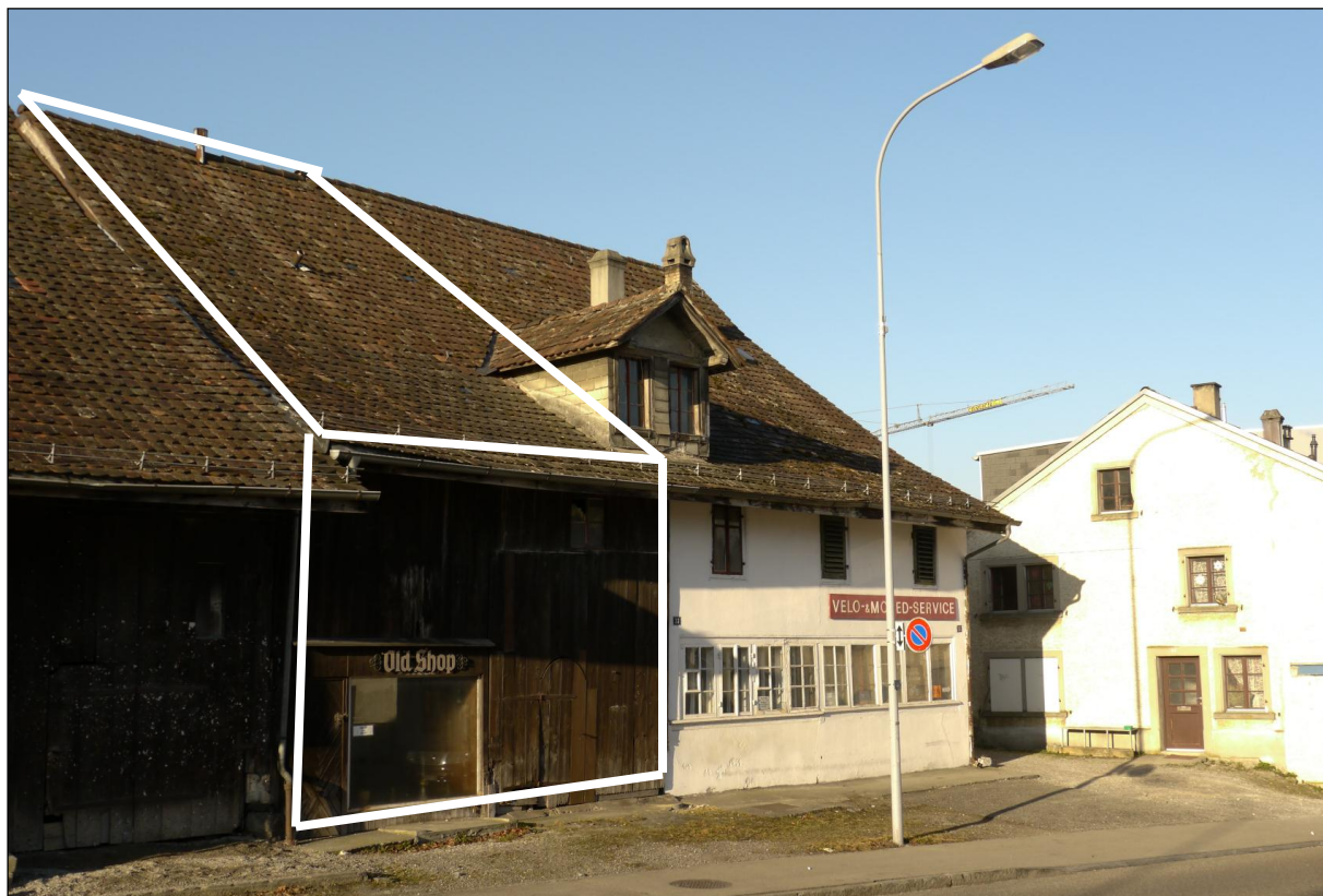
Abb. 61: B: Von zwei bis drei Parteien genutzte Ökonomie. Dieser Bau schloss die 27 Meter lange Fassadenflucht des Gebäudekomplexes.
