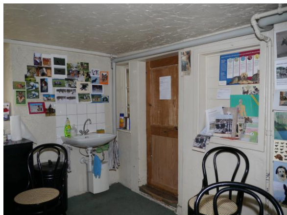
Abb. 93: Raum 0.05, Blick Richtung Südosten.
