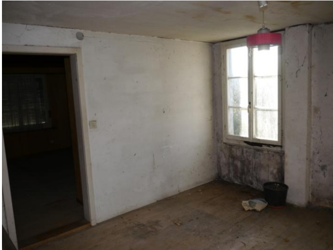
Abb. 199: Raum 2.12, Blick Richtung Südwesten.
