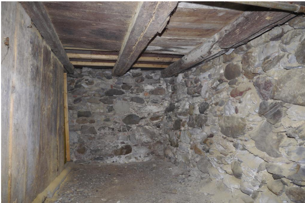
Abb. 47: Nördlicher Teil des Kellers. Die Deckenbalkenlage ist sekundär eingesetzt.
