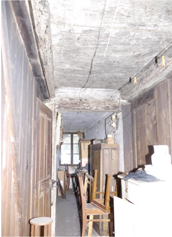
Abb. 162: Raum 1.11, Blick Richtung Süden.
