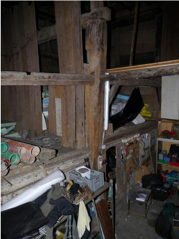
Abb. 110: Raum 0.14, Blick Richtung Südosten. Ehemaliger Eckständler der 1. Bauphase.
