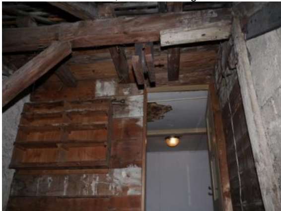
Abb. 210: Raum 2.18, Blick Richtung Süden.
