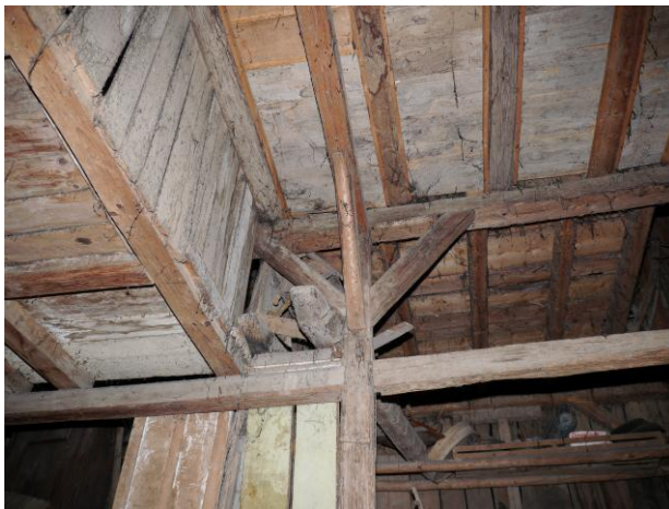
Abb. 121: Raum 0.16, Blick Richtung Osten.
