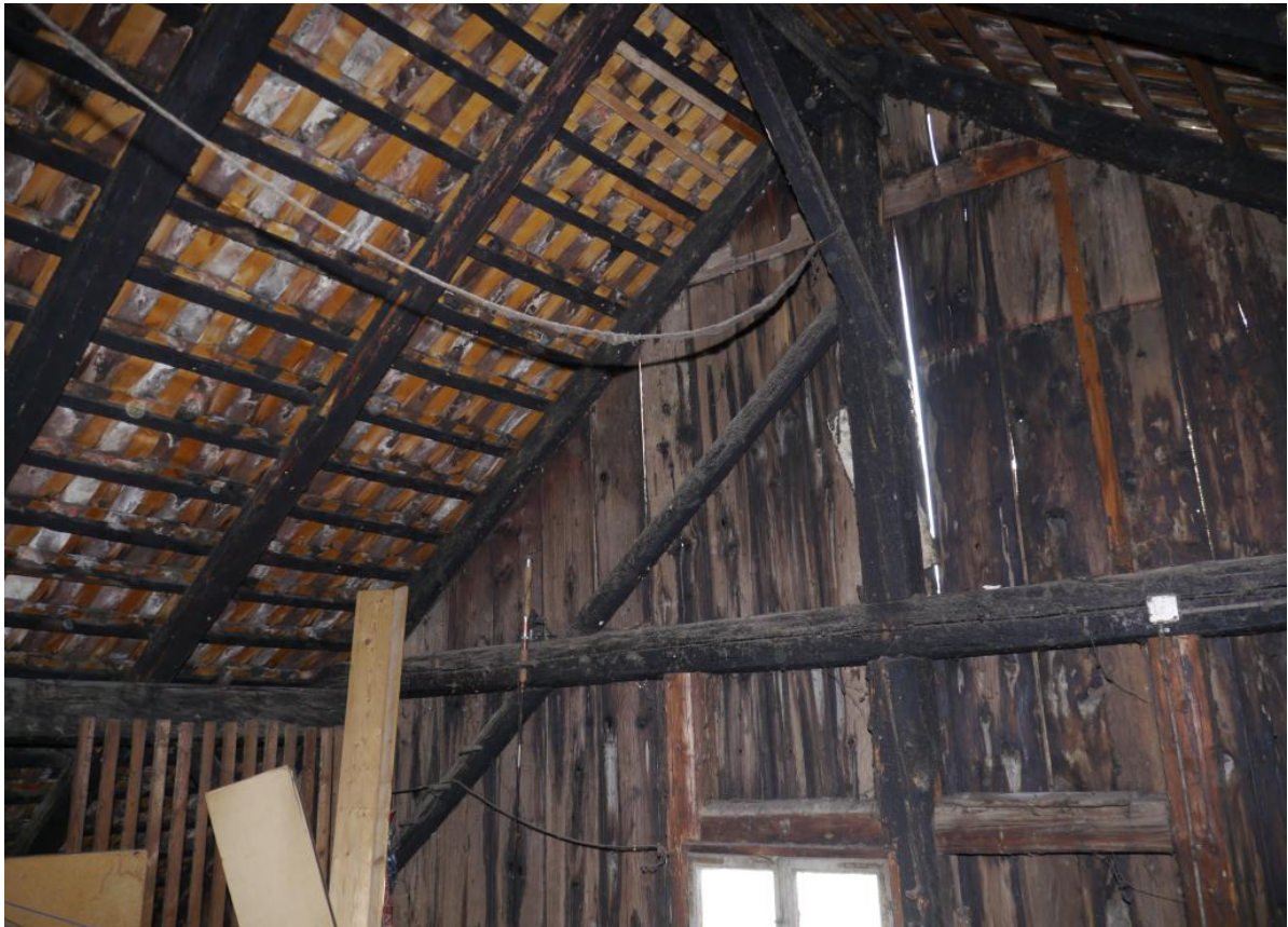
Abb. 44: Den östlichen Abschluss des Dachwerks bildet ein Querbinde mit einem Bretterschirm.
