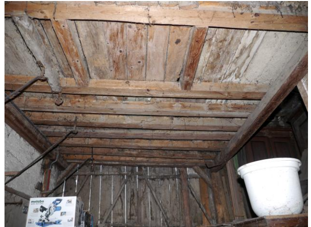
Abb. 120: Raum 0.16, Blick Richtung Norden. Detail Brüggli.
