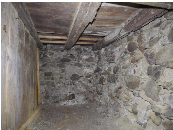
Abb. 80: Raum -0.03, Blick Richtung Westen.
