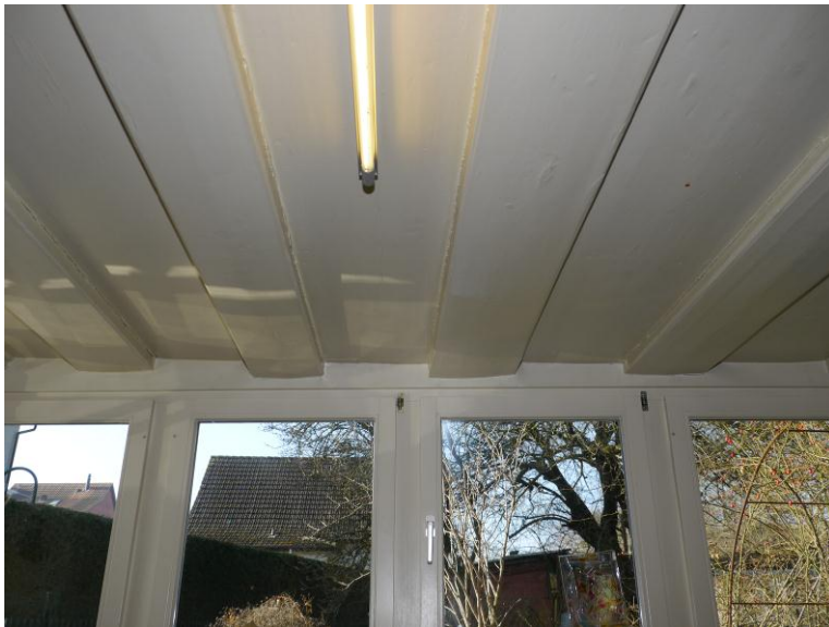
Abb. 94: Raum 0.06, Blick Richtung Süden mit Bohlenbalkendecke.
