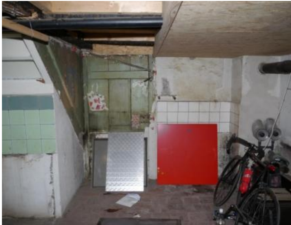
Abb. 102: Raum 0.10, Blick Richtung Osten.
