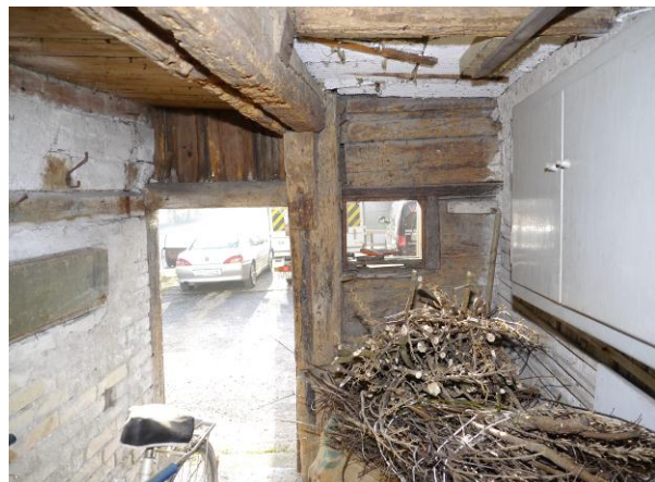
Abb. 87: Raum 0.02, Blick Richtung Osten mit ursprünglichem Nordost-Eckständer und Nute der 1. Bauphase.
