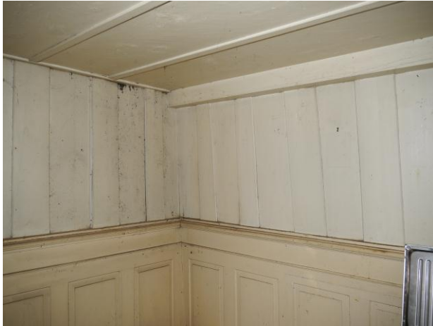
Abb. 173: Raum 1.18, Blick Richtung Nordwesten.
