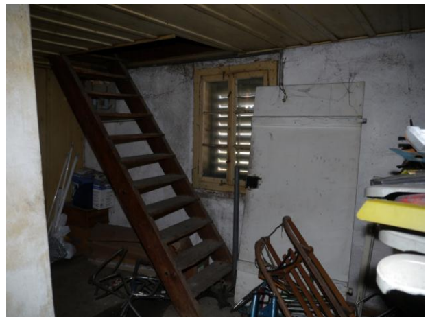
Abb. 201: Raum 2.13, Blick Richtung Westen.
