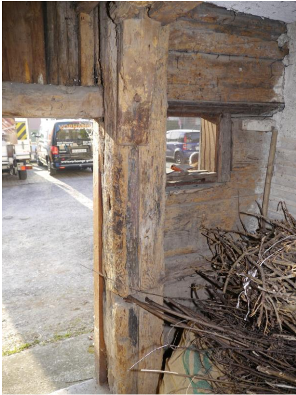
Abb. 38: Ostfassaden Ständer (Raum 0.02) mit originaler Bohlenwand und Nut für eine abgegangene Wand.
