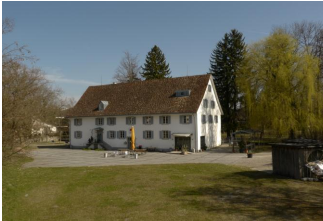
Abb. 6: ehemalige Obere Mühle.
