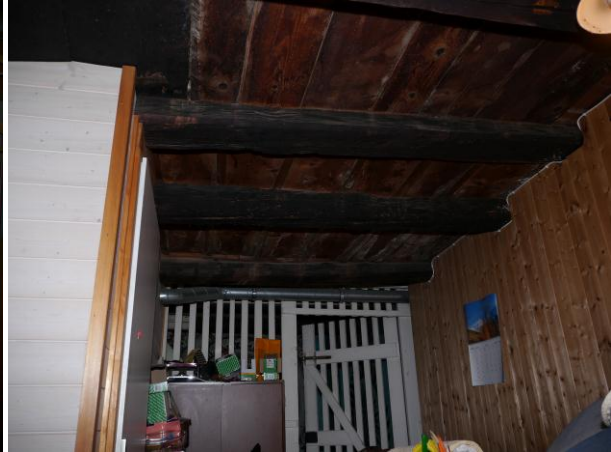
Abb. 150: Raum 1.02, Blick Richtung Westen.
