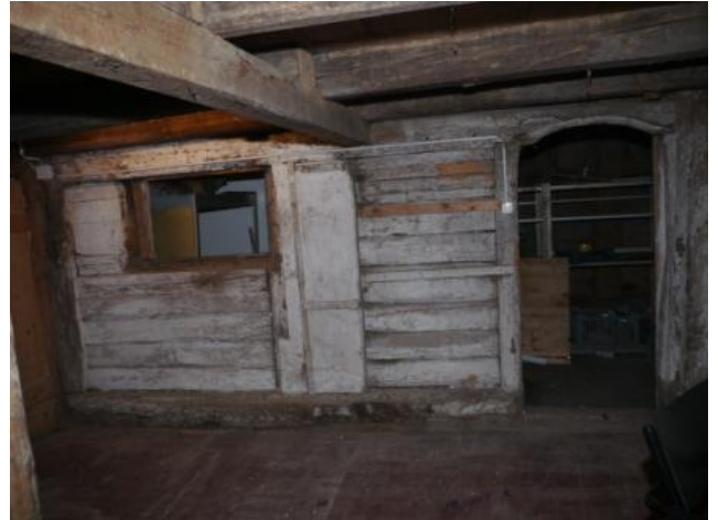
Abb. 99: Raum 0.09, Blick Richtung Südwesten. Profilierte Rundbogentüre und Schwelle der 1. Bauphase.
