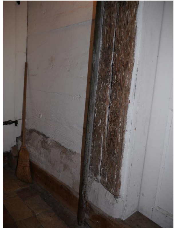
Abb. 91: Raum 0.04, Detail des genuteten Firstständers der 1. Bauphase.
