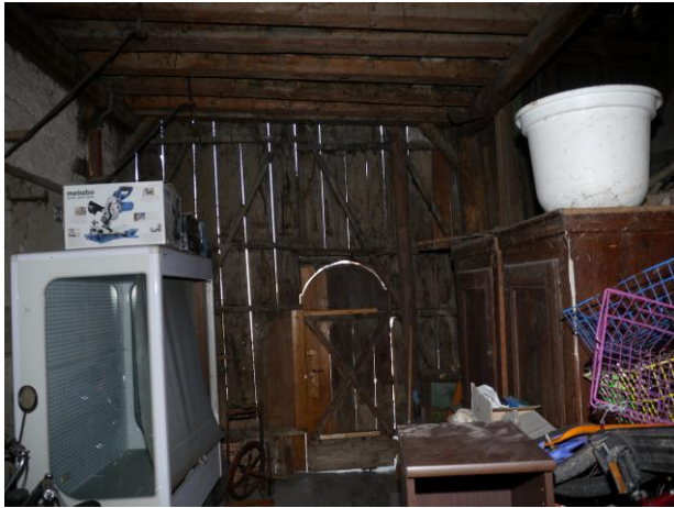
Abb. 119: Raum 0.16, Blick Richtung Norden.
