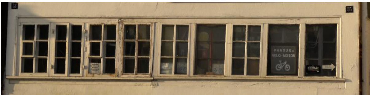
Abb. 57: Die beiden breiten Fensterwagen im Erdgeschoss zeugen von der textilen Heimarbeit.
