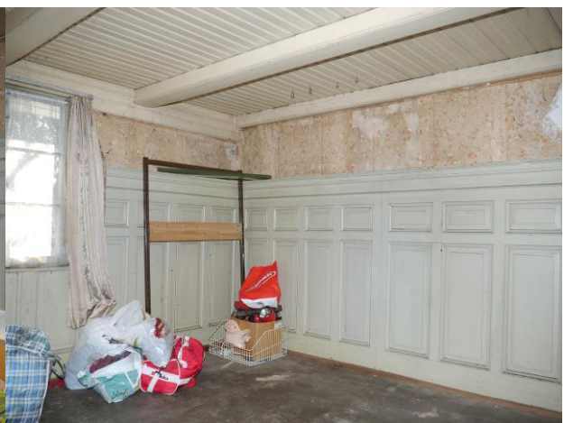
Abb. 170: Raum 1.16, Blick Richtung Südwesten.
