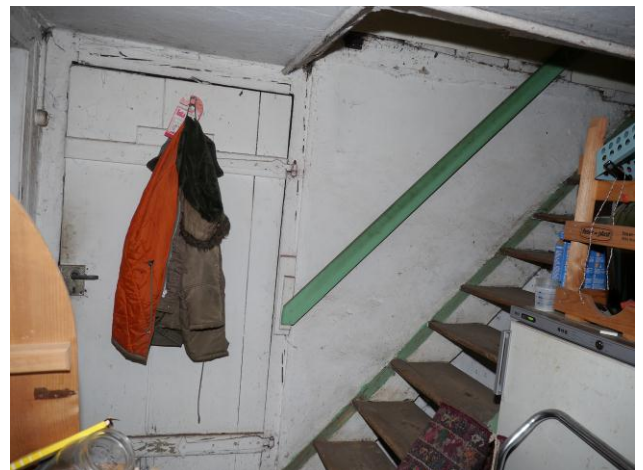
Abb. 126: Raum 0.18, Blick Richtung Westen mit Türe zu Raum 0.28.
