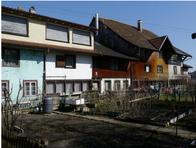
Abb. 74: Südfassade mit östlichem Hausteil.
