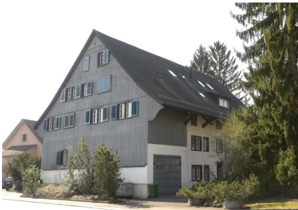
Abb. 8: Oberdorfstrasse 8/10, ursprünglicher Lehenhof.
