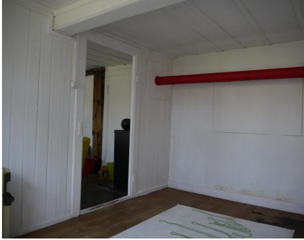
Abb. 105: Raum 0.11, Blick Richtung Nordwesten.
