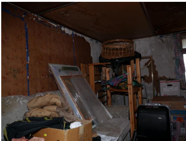
Abb. 182: Raum 1.23, Blick Richtung Nordwesten.
