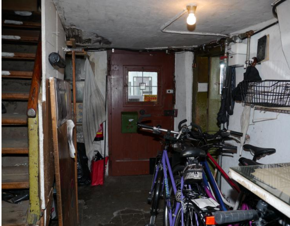
Abb. 134: Raum 0.23, Blick Richtung Westen.
