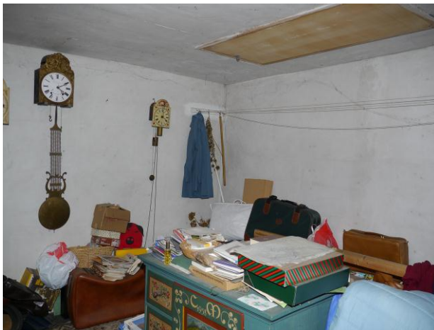
Abb. 196: Raum 2.10, Blick Richtung Nordost.
