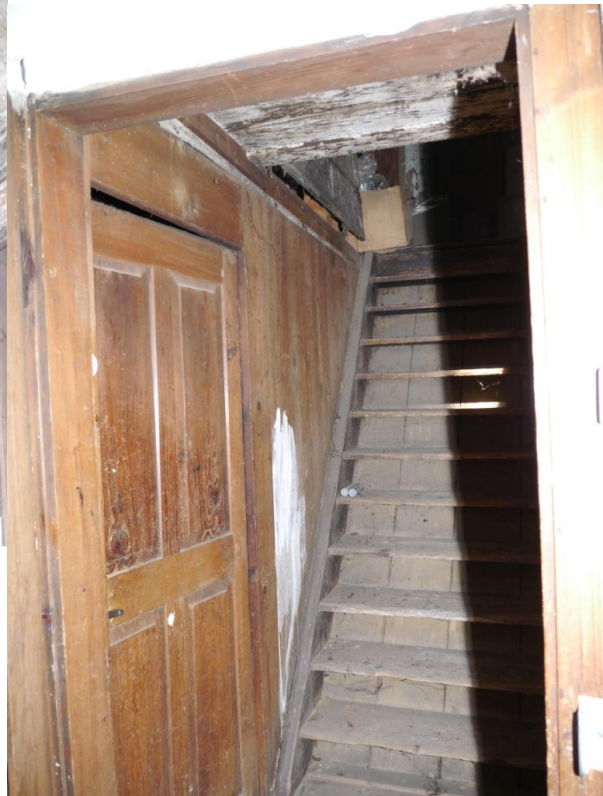
Abb. 163: Raum 1.12, Blick Richtung Norden.
