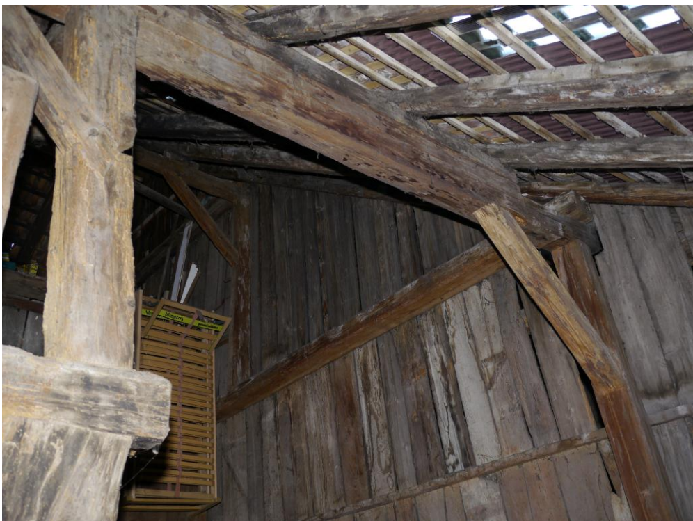
Abb. 111: Raum 0.14, Blick Richtung Westen. Erneuerte Westwand Konstruktion.
