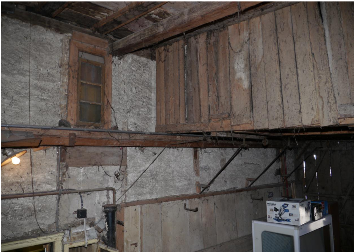
Abb. 63: Älterer, westlicher Abschluss der Ökonomie. Die Türe, Fenster und Aussenverputz belegen, dass der Bau aus der Phase V an dieser Stelle frei stand.
