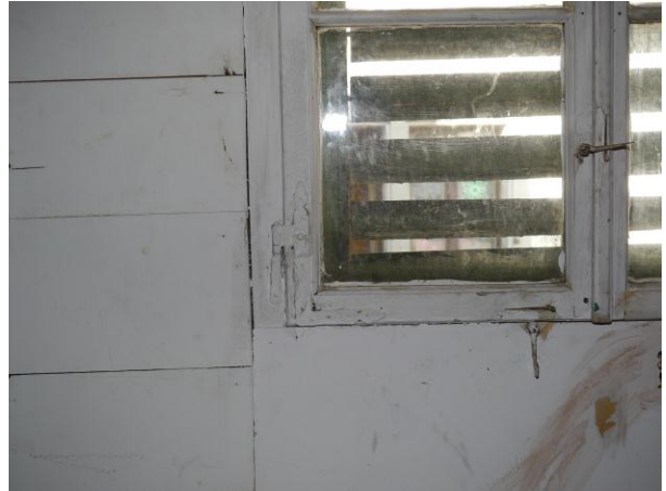
Abb. 178: Raum 1.20, Blick Richtung Norden. Eckbeschläge mit Eichelabschluss.
