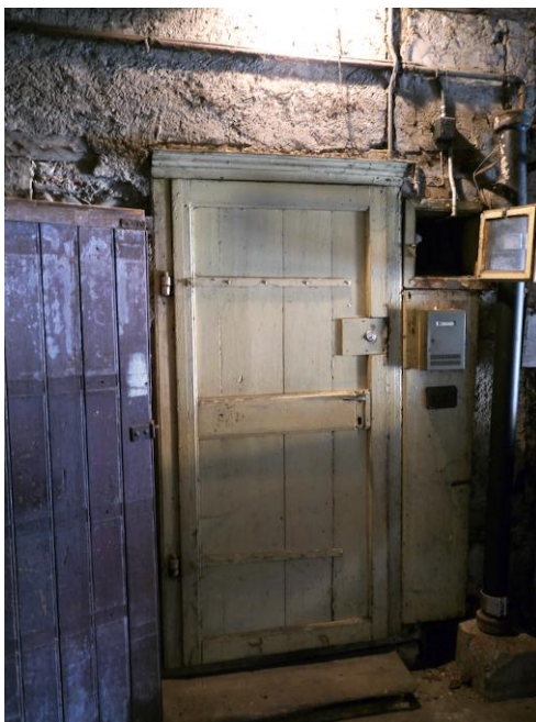
Abb. 123: Raum 0.16, Blick Richtung Westen. Ehemalige Haustüre zu Raum 0.21.
