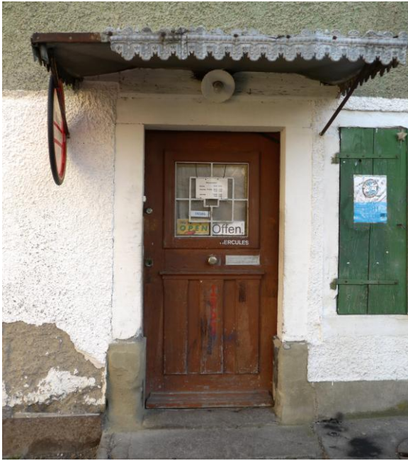
Abb. 55: Eingang in den westlichen Hausteil mit der ursprünglichen Türe aus dem Spätbiedermeier. Das blecherne Schutzdach ist nachträglich angefügt.
