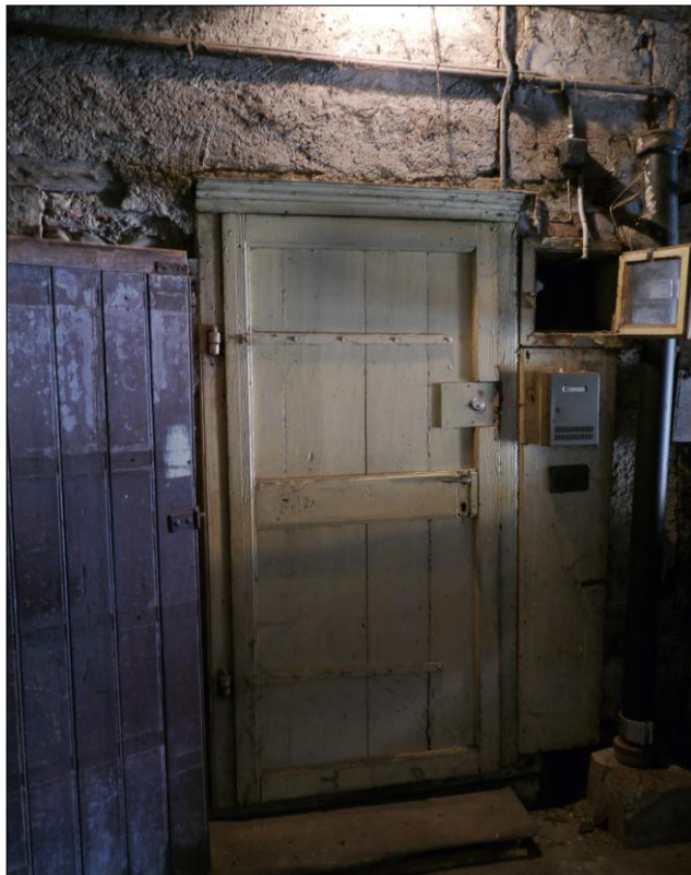
Abb. 53: Der Eingang in den östlichen Teil der Liegenschaft befindet sich im anschliessenden Tenn.
