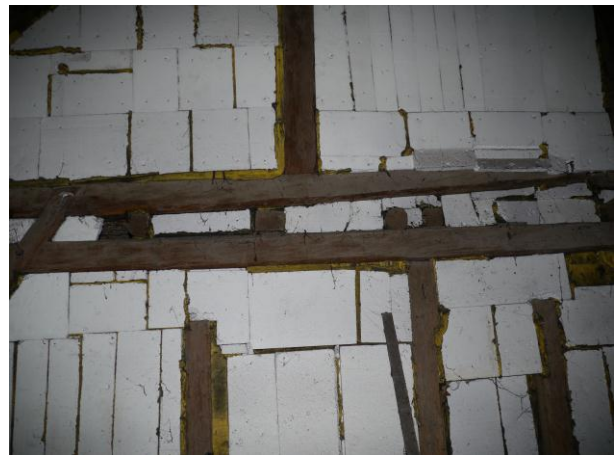
Abb. 115: Raum 0.14 (über Raum 0.01) Blick Richtung Süden.
