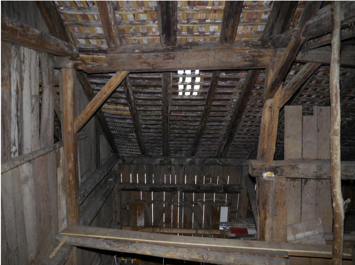
Abb. 112: Raum 0.14, Blick Richtung Norden. Erweiterung durch Pfetten.
