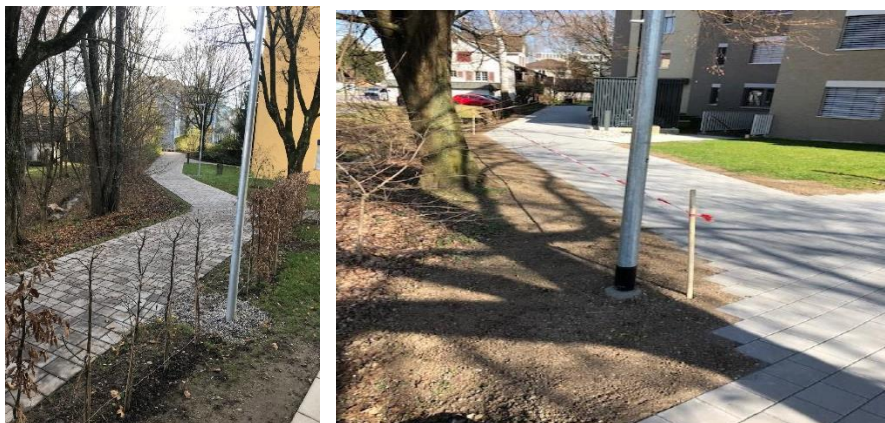
Legende: Bauarbeiten Zipartenstrasse
